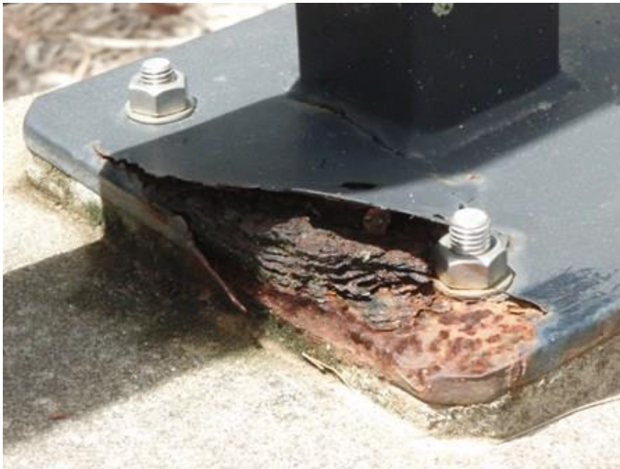
KUVA 3. Rakokorroosio (Kuva: Welke R.)
