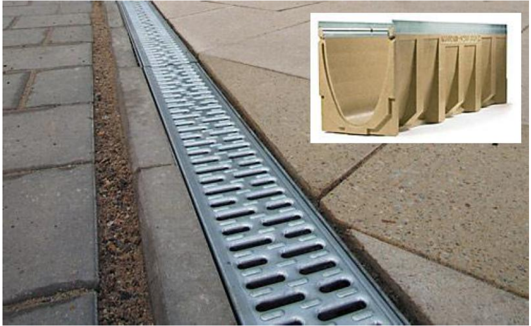
KUVA 3. Aco Drain Multiline -kouru asennettuna pihalle. Yläkulman pienemmässä kuvassa näkyy kourun rakenne. Kuvan kouru on eurooppalaisen standardin EN 1433 mukainen ja sen maksimikuormitus on 25 tonnia. (Kuvat: Kivikopla Oy 2013.)
