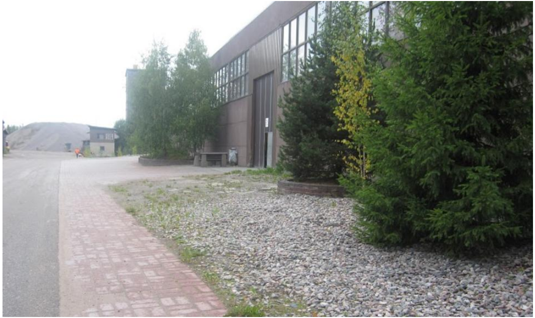
KUVA 12. Eteläisen hallin seinustalla olevia kattovesien imeytyspisteitä. Kuva on otettu idästä länteen päin. Allas tulisi tässä suunnitelmassa kuva-alan vasemmalle puolelle. (Kuva: Mika Sirviö 2012.)
