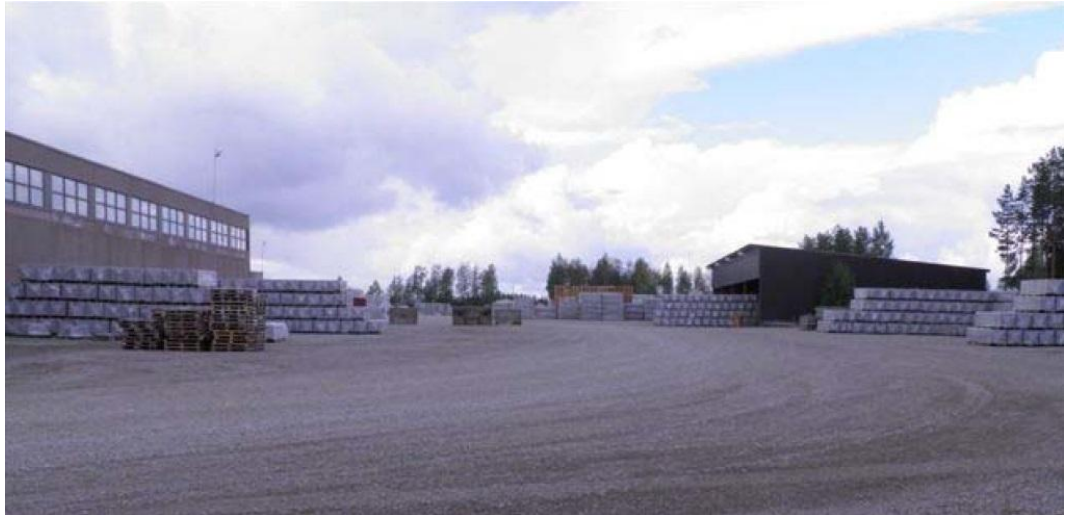
KUVA 5. Lastausalueen nykytilanne idästä länteen päin katsottuna (Rakennusbetoni- ja Elementti Oy 2012a)
