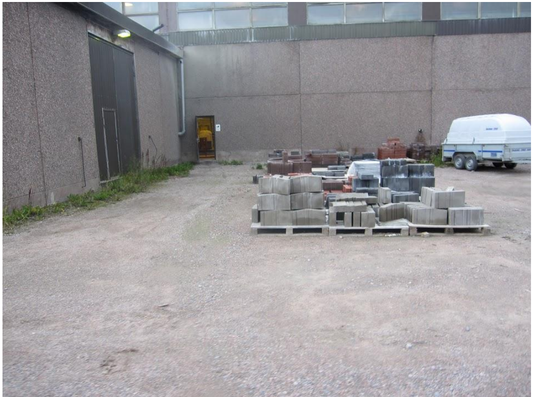
KUVA 7. Valokuva välipihan ongelmallisesta kohdasta, jossa matalamman rakennuksen katolta tuleva purkuputki syöksee sateella vettä suoraan kulkuväylälle oven eteen (kuva: Mika Sirviö 2012)
