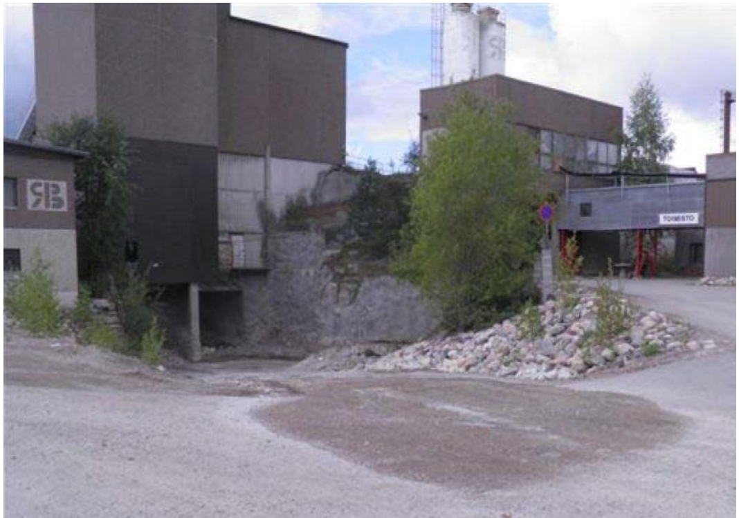
KUVA 13. Valokuva betoniaseman edessä olevasta kaltevasta ajoluiskasta, jonne hulevedet nykyisin usein valuvat (Rakennusbetoni- ja Elementti Oy 2012a)
