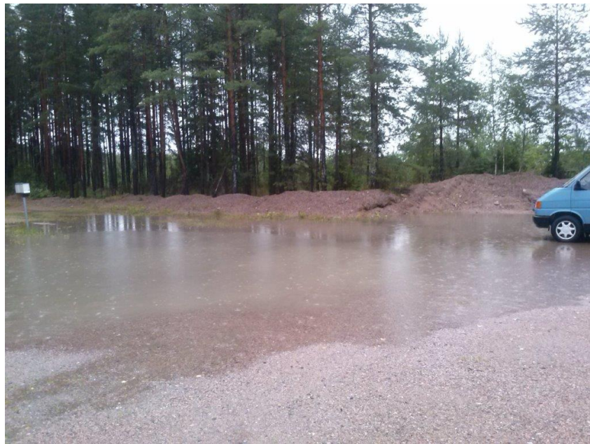
KUVA 11. Suuri lammikko Rakennusbetoni- ja Elementti Oy:n nykyisellä parkkipaikalla. Kuva on otettu rankkasadepäivänä elokuussa 2013. (Hallikainen 2013.)
