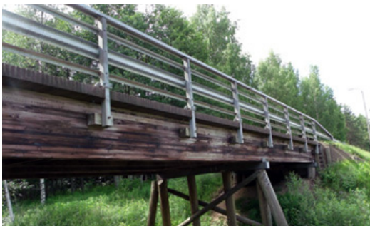
Kuva 9. Siltapalkit, perustukset ja kaiteen kiinnitys.
