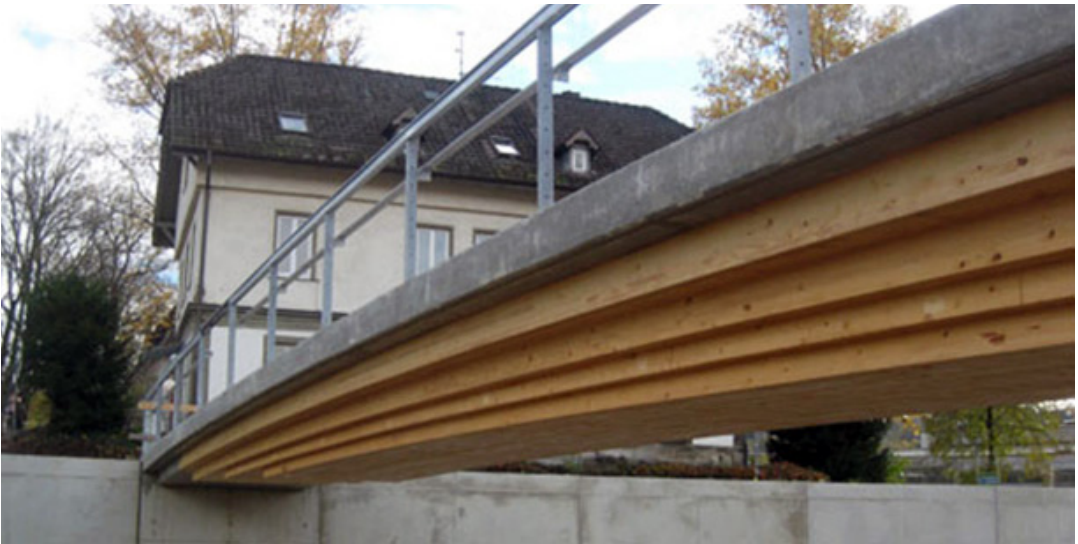
Kuva 11. Puu-betoni -liittolaattasilta, Schwäbin Gmünd, Saksa.
