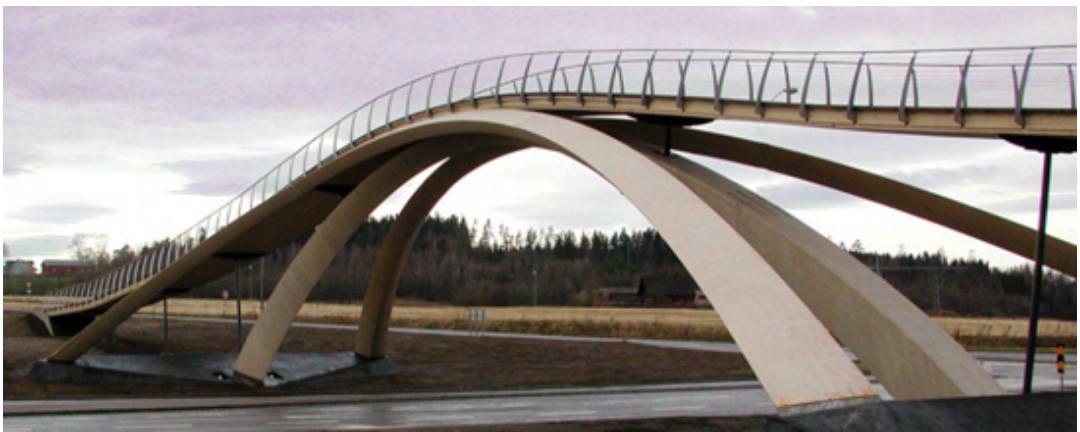
Kuva 1. The Leonardo -kevyen liikenteen silta, Oslo, Norja. Kuva: Moelven Limtre AS.
