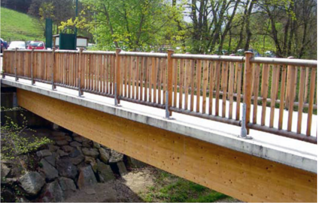
Kuva 12. Puu-betoni -liittorakenteinen liikennesilta Itävallassa.
