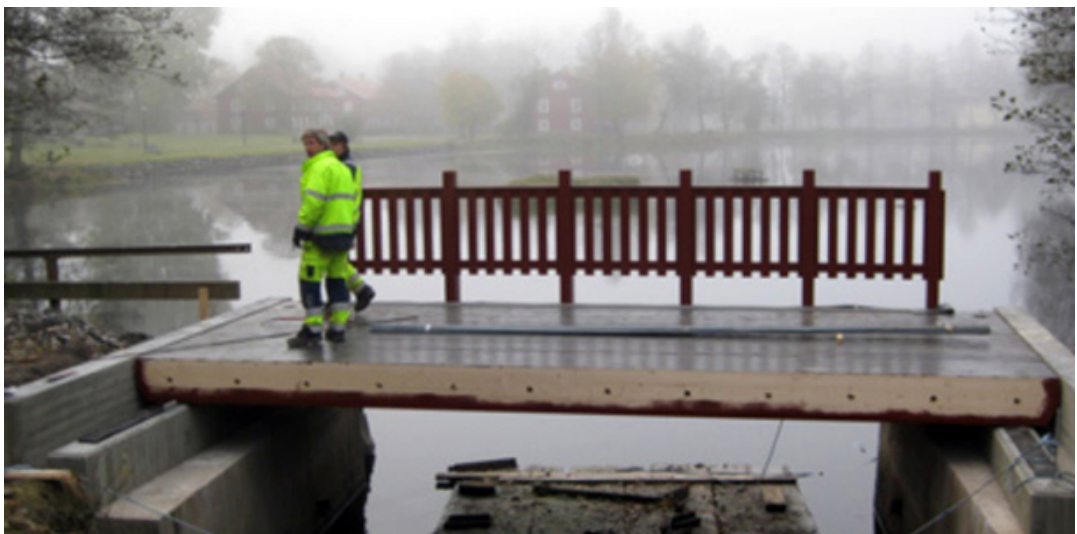
Kuva 3. Laattasillan kannen osa asennettuna. Kuva: Martinsons Träbroar.
