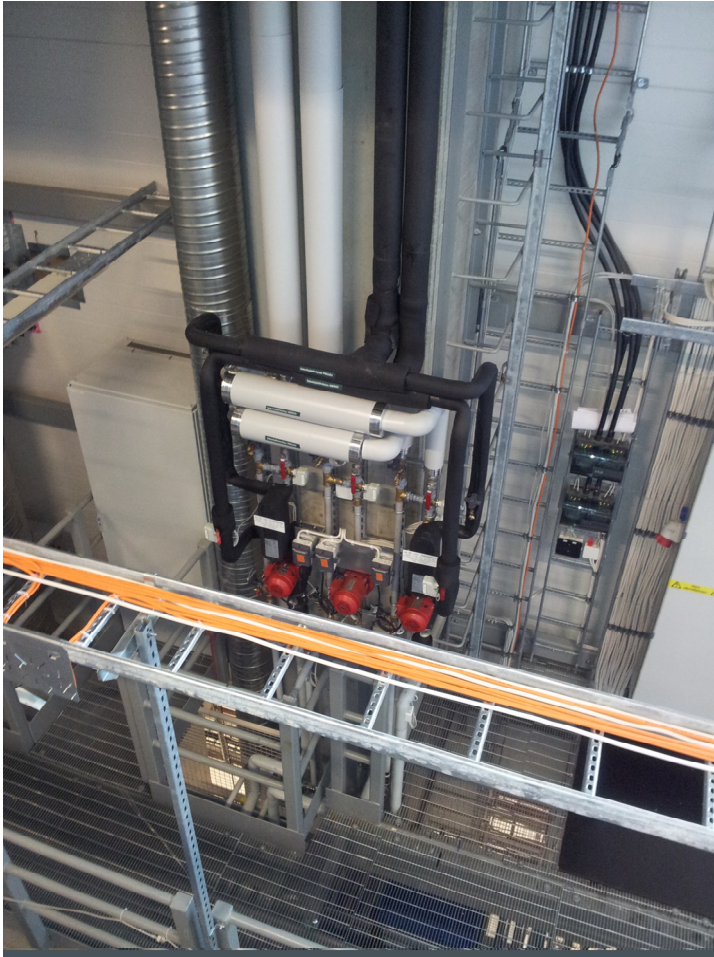
Kuva 3. Tilanpuutteesta johtuen säteilypiirin pumppuryhmä on sijoitettu huoltosillalle.
