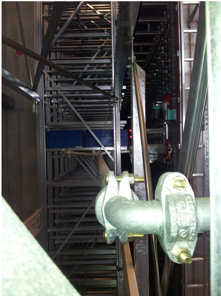
Kuva 4. Sammutusjärjestelmän runkoputki on asennettu vinoon. Perusteellinen laadunvarmistus karsii pienetkin virheet.
