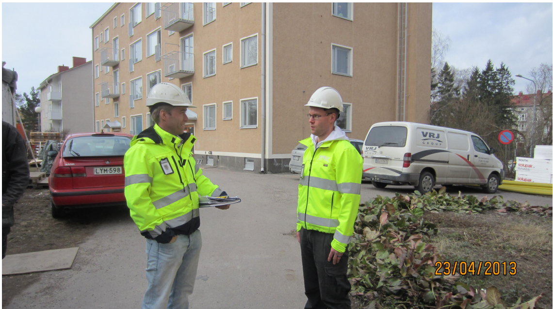
Kuva 1. Suullista tiedonkulkua linjasaneeraustyömaalla.
