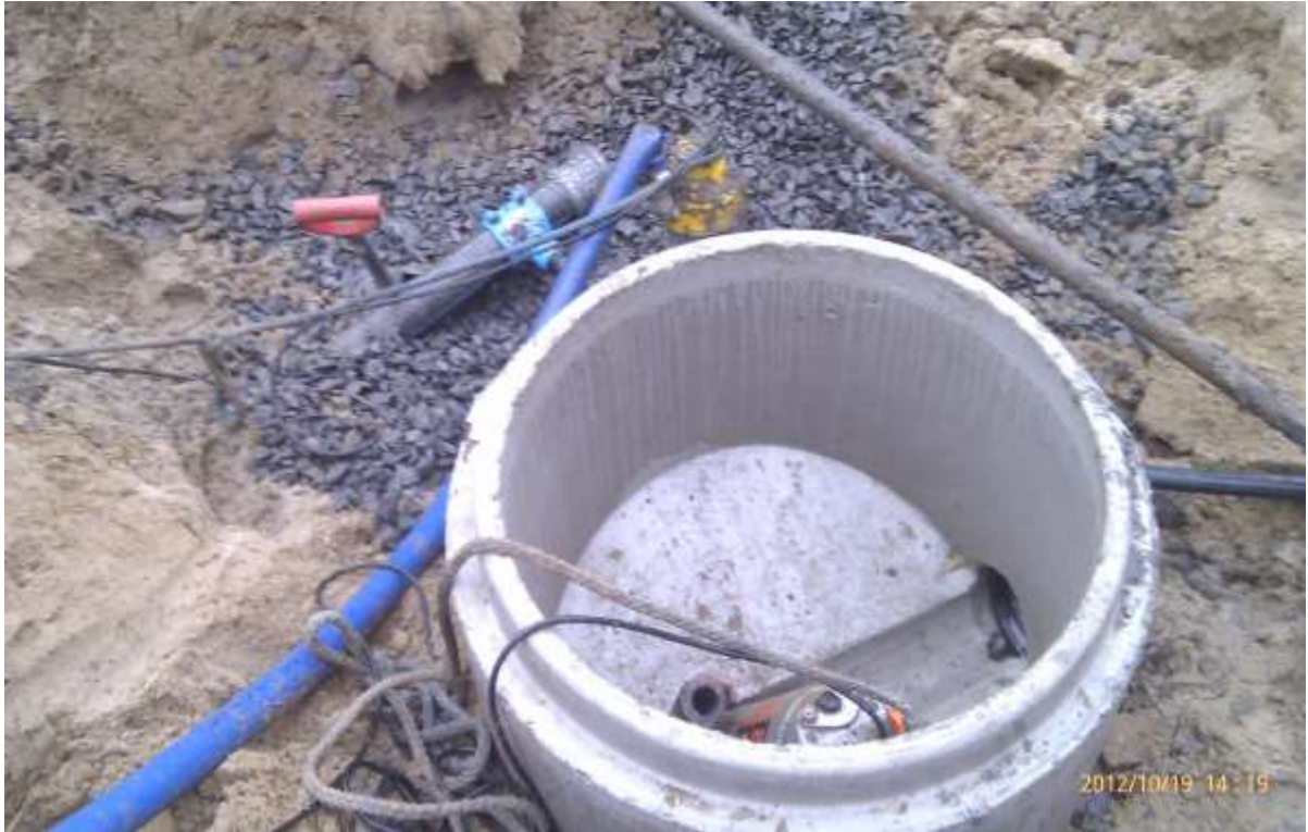
KUVA 2. Vanhalle jätevesiviemäriille tehtävä ohipumppaaminen
