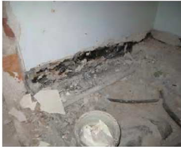
Pesuhuoneen lattia purettu
