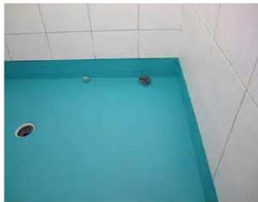
Lattia on vedeneristetty.
