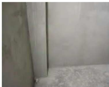
Lattia ja seinät tasoitettu
