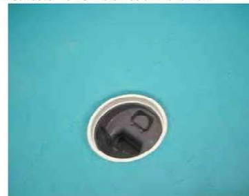
Lattiakaivo on tehty asianmukaisesti.
