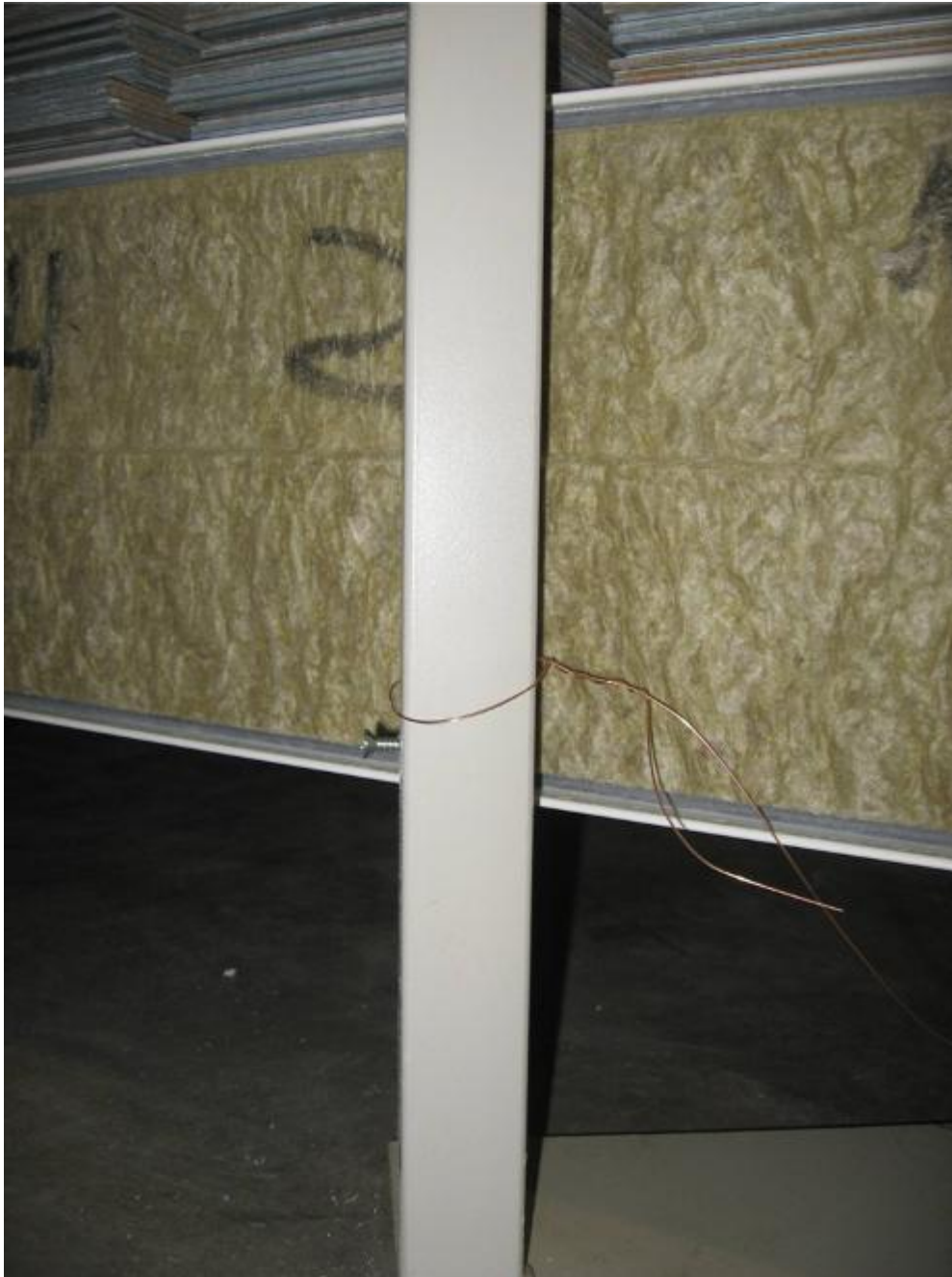
Kuvio 21. Tuntilaskurin vastakappale, johon on kiinnitetty teräslanka ja kiristetty paikoilleen testipaneelin alle.
