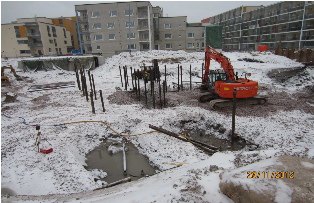
Kuva 8. Paalut ennen katkaisua
