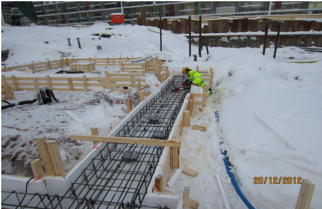
Kuva 9. Anturat ennen betonointia
