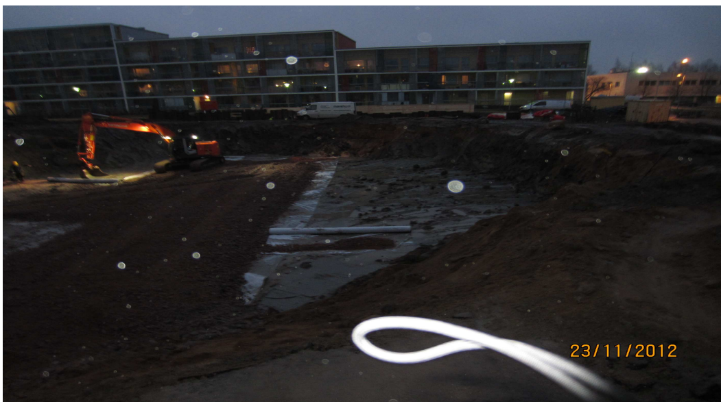
Kuva 4. Suodatinkankaan sekä murskeen levitystä
