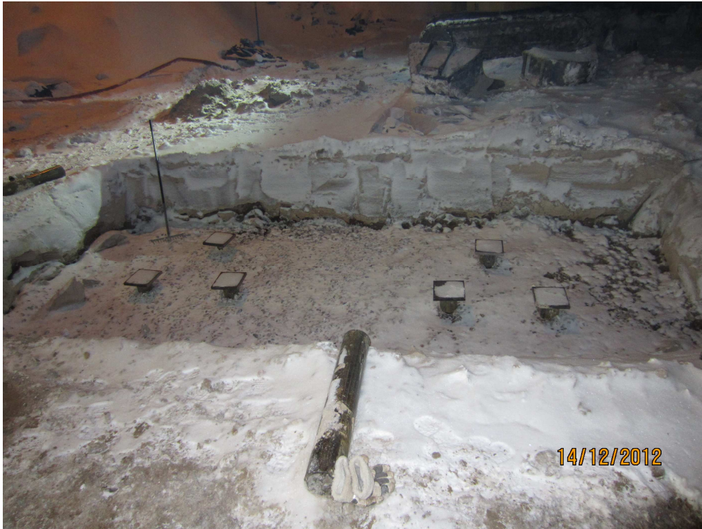
Kuva 11. Paalut katkaisun ja betonoinnin jälkeen
