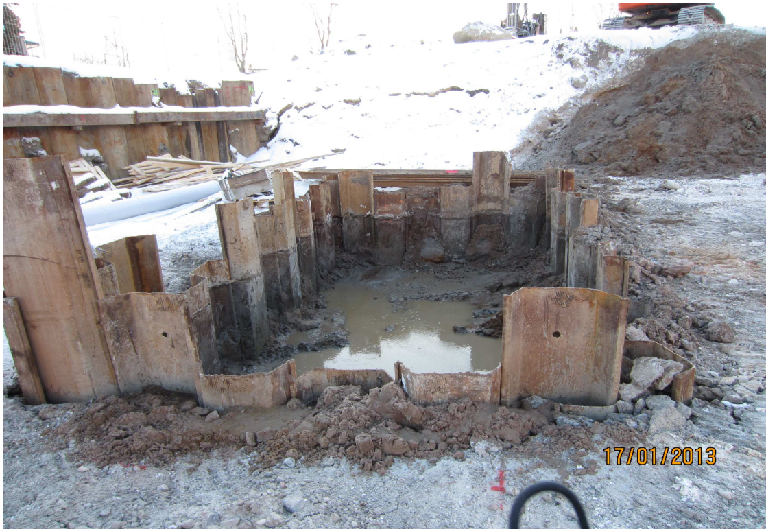
Kuva 6. Pumppaamon paikka pontattuna
