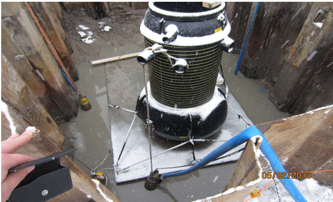
Kuva 7. Pumppaamot kasattiin maanpäällä ja nostettiin kokonaisina osina oikeaan paikkaan
