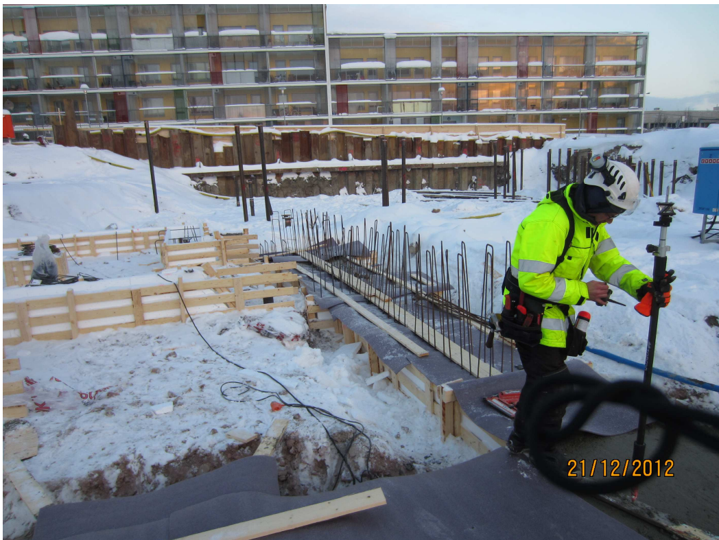
Kuva 10. Anturat suojattuna pakkasmatolla. Mittamies merkkää tartuntojen sijainteja
