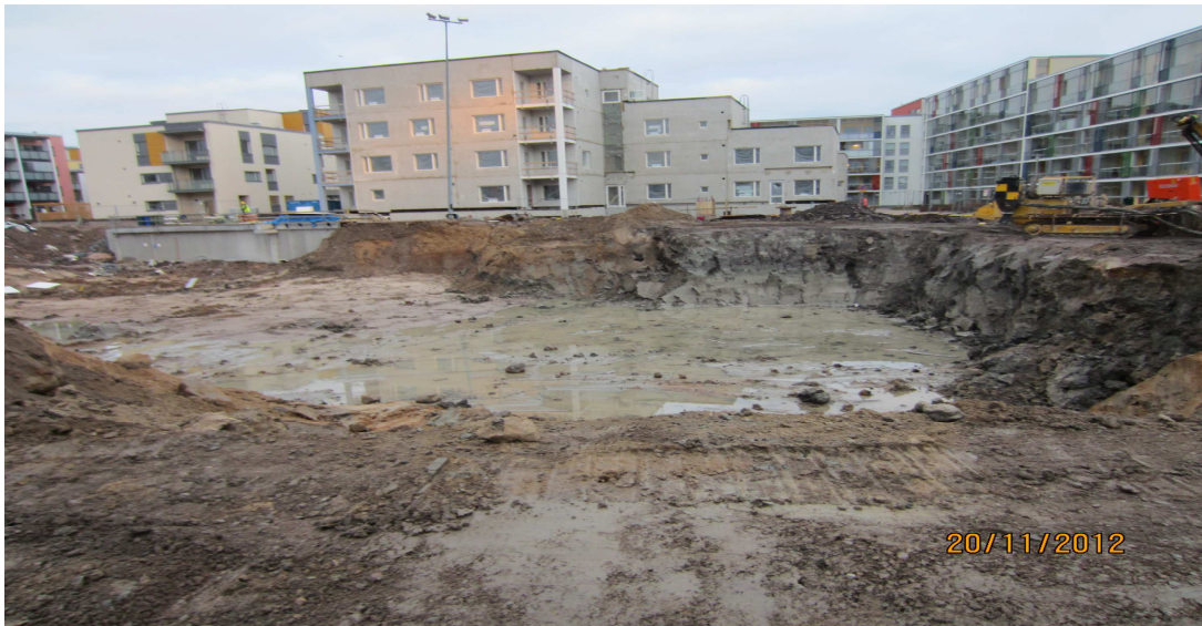
Kuva 3. Pohja maankaivuun jälkeen ennen paalutuspedin tekoa
