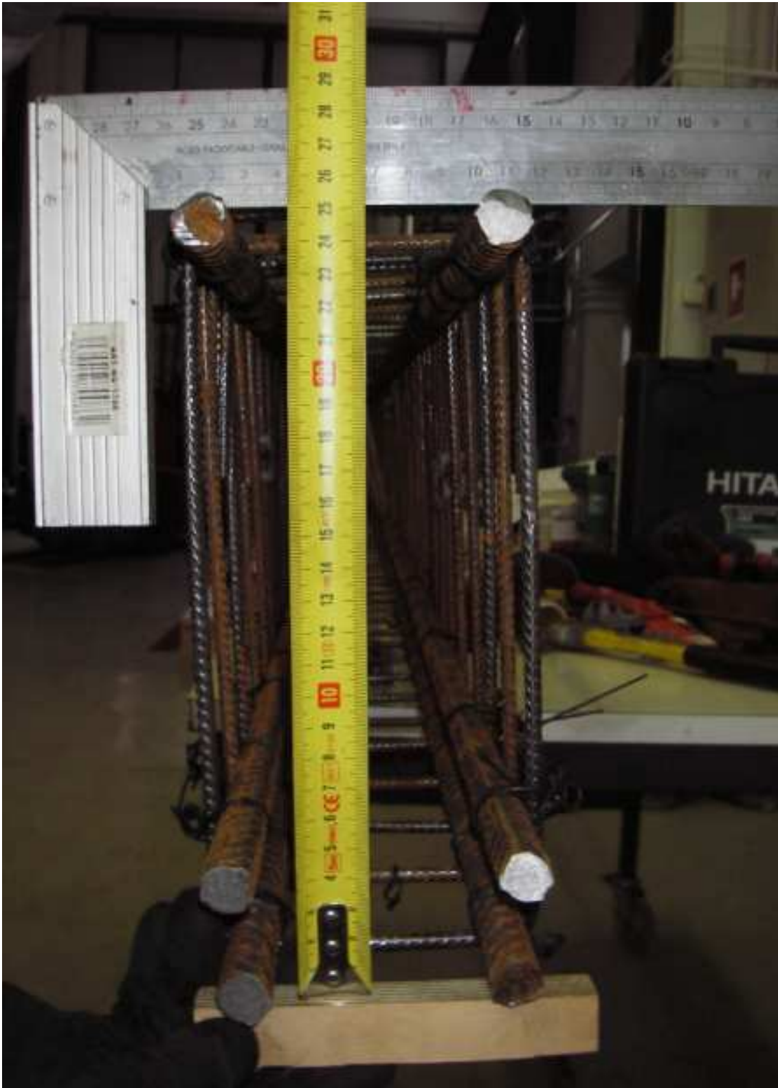
KUVA 3. Valmiin ankkurointipalkkiraudoitteen mittojen tarkistus, viitattu luvussa 8.7.2 (Pesonen 2012)
