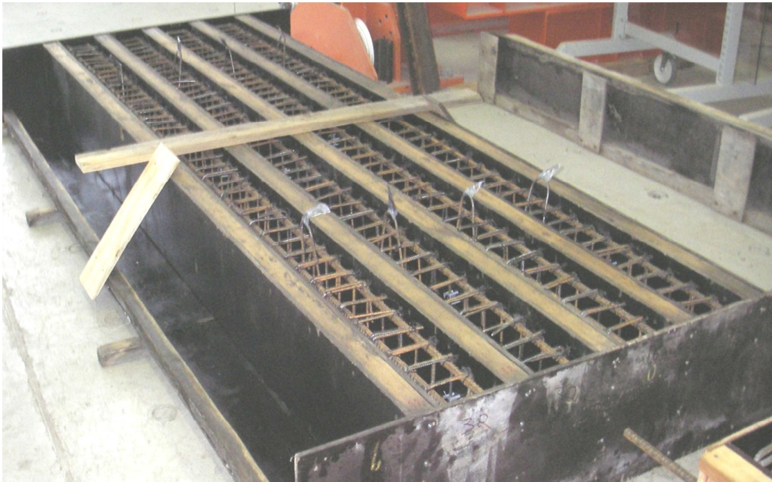
KUVA 33. Ankkurointipalkkien muotit raudoitteineen ennen lisäpuristusraudoitteiden asennusta (Pesonen 2012)
