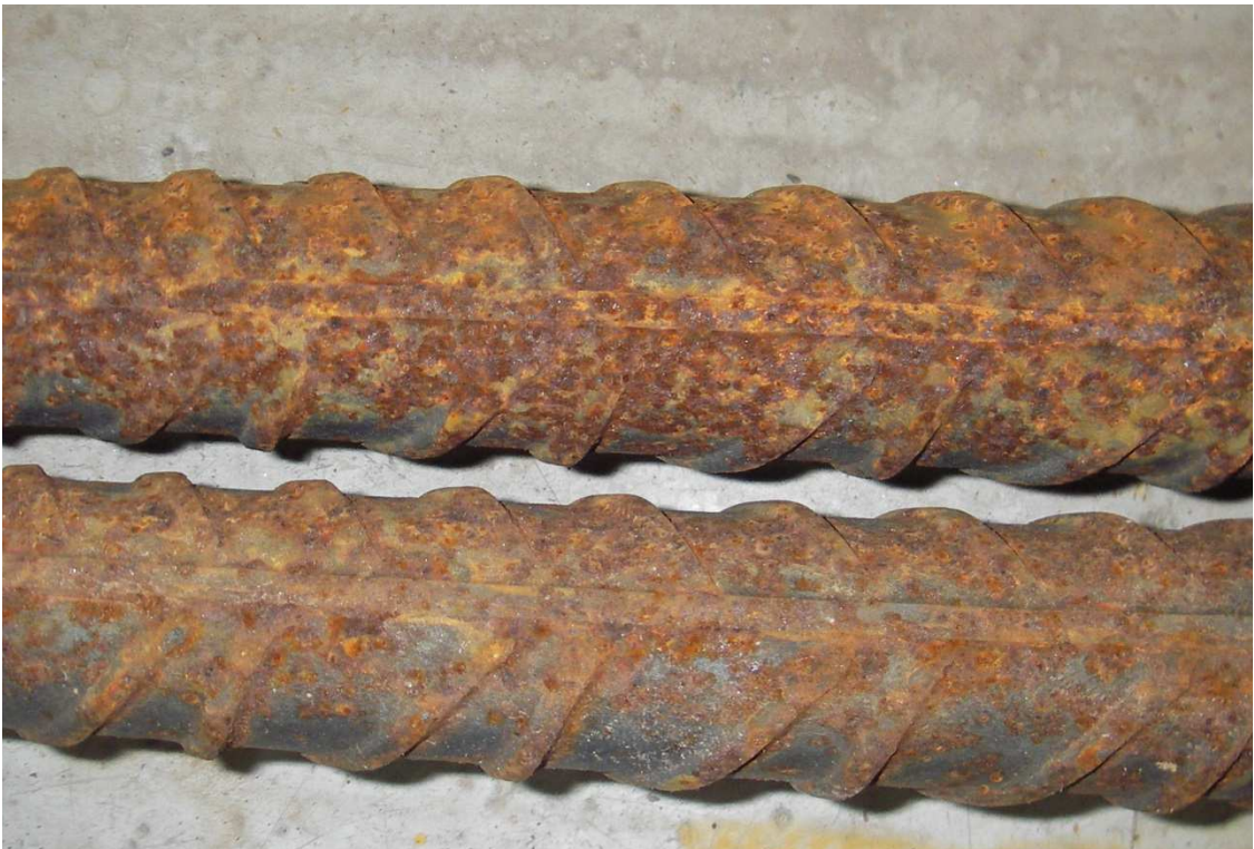
KUVA 29. 32 mm tankojen pintakorrosioaste ennen harjausta (Pesonen 2012)
