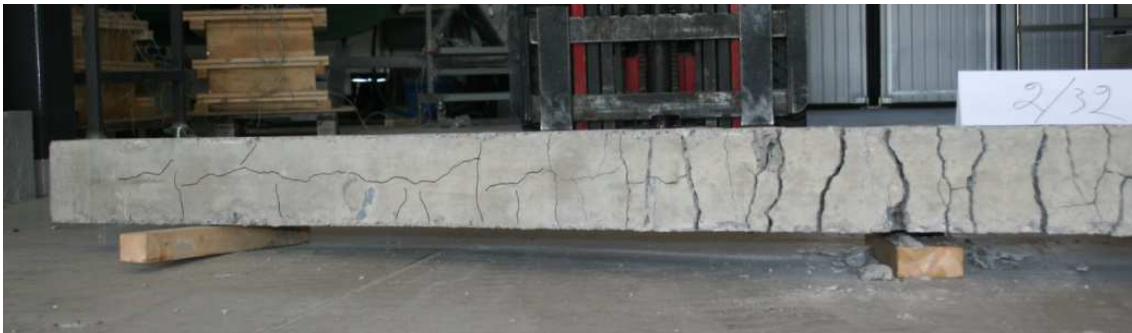
KUVA 52. Pitkittäshalkeama 32 mm:n tangolla raudoitetun ankkurointipalkin alapinnalla (Pesonen 2012)
