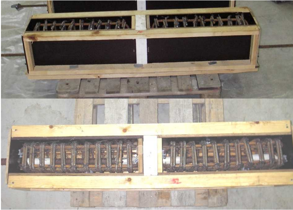
KUVA 31. Tartuntatestipalkin muotti raudoituksineen ennen betonointia (Pesonen 2012)
