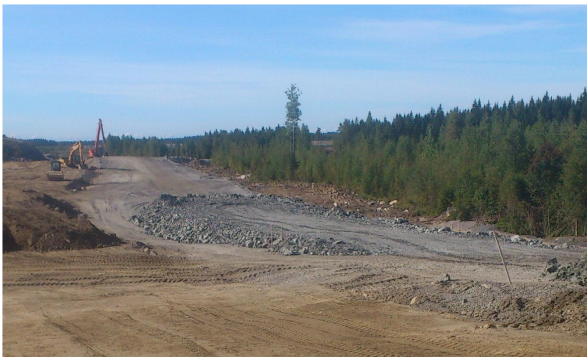
Kuva 32. Tukipenkereeseen on ajettu louhetta vaakasuodattimen päälle (Ruotsalainen 2013-08-24.)
