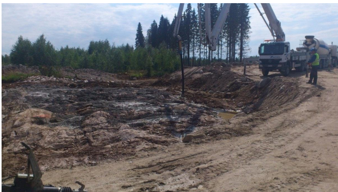
Kuva 25. Kuvan 24 kalliot betonoitavina (Ruotsalainen 2013-7-5)
