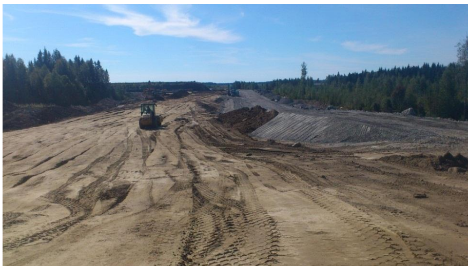
Kuva 37. 0 - 32 mm murskeesta rakennettu vinosuodatin osittain peitettyä moreenilla. Vasemmalla myös täryjyrä työn touhussa (Ruotsalainen 2013-08-27.)
