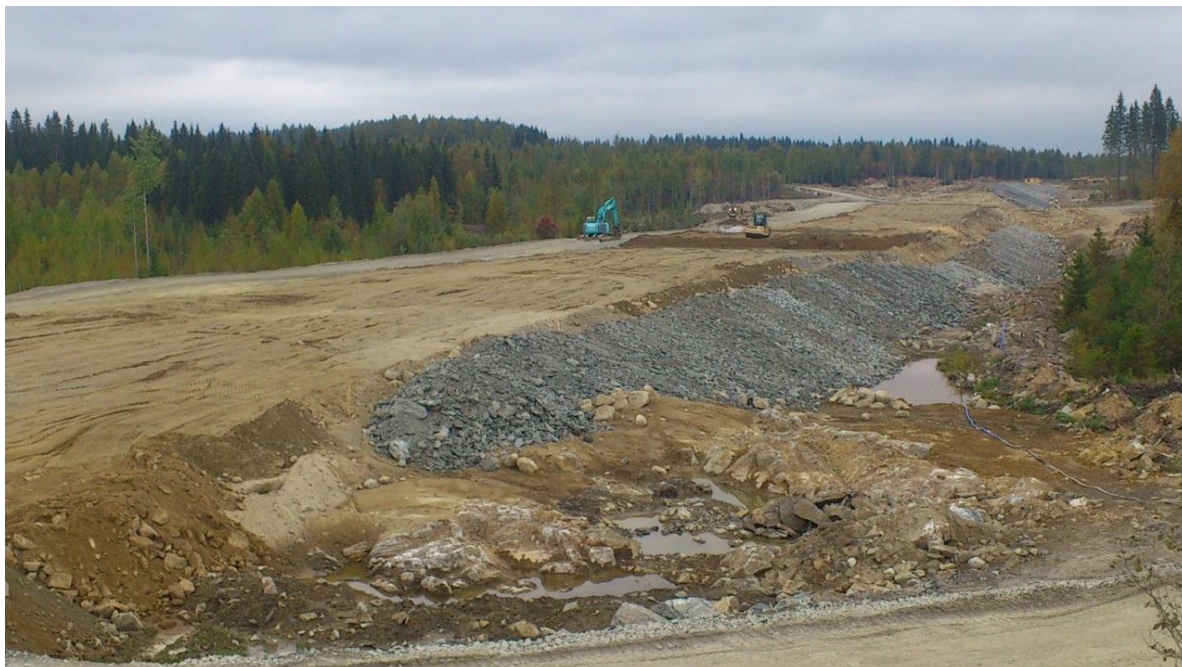
Kuva 33. Kuvassa näkyy moreenista tiivistyssydäntä sekä louheverhousta (Ruotsalainen 2013-09-11.)
