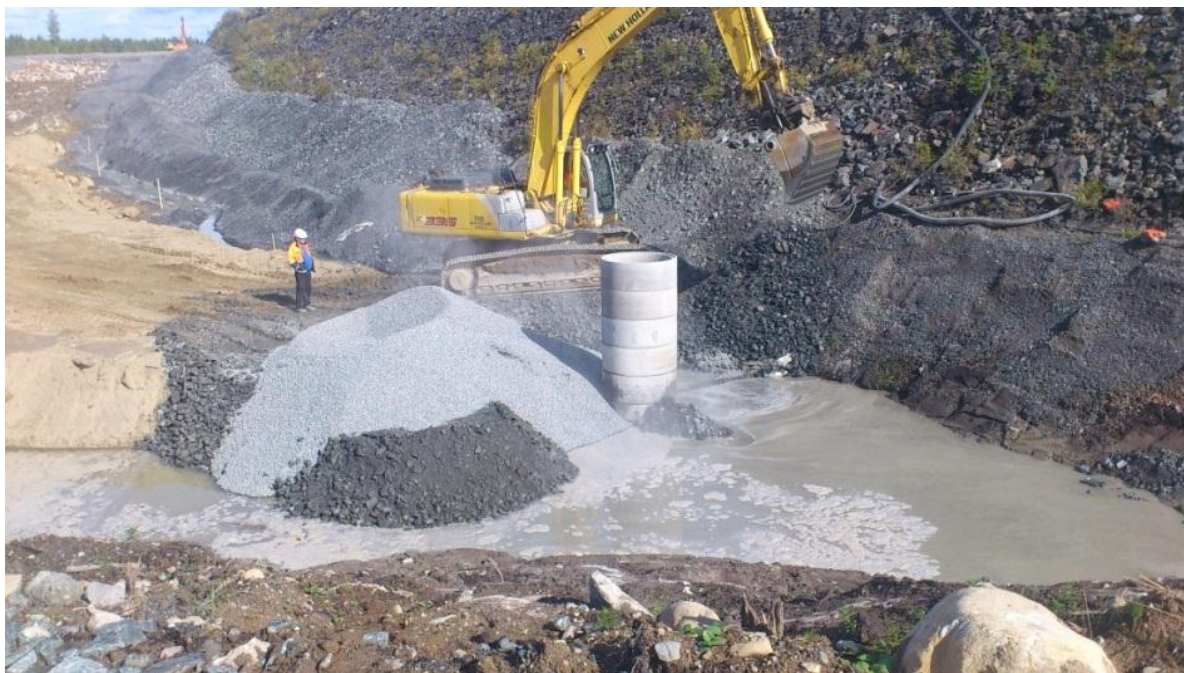
Kuva 38. Kaivorakennetta rakennetaan paalulle 3800 moreenisen tiivistesydämen sisään (Ruotsalainen 2013-09-04.)
