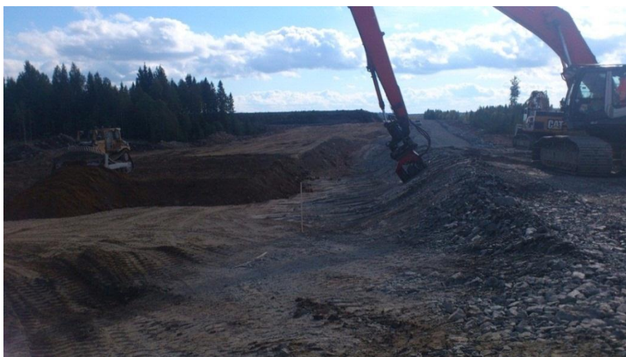
Kuva 36. Tärylevyllä tiivistetään karkeasuodatinta. Vasemmalla näkyy myös puskkone työntämässä moreenia noin metrin kerroksena (Ruotsalainen 2013-08-26.)
