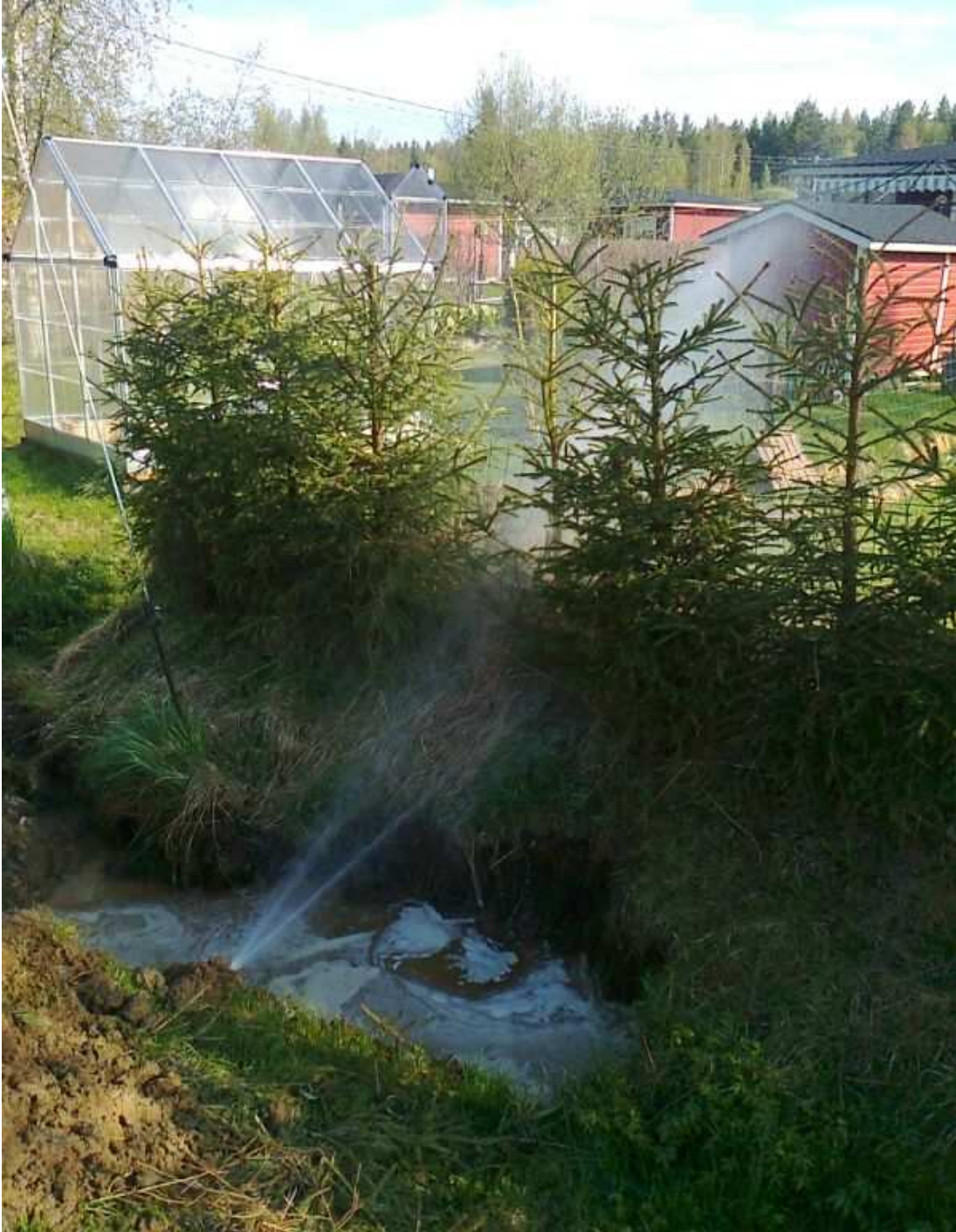
KUVA 2. Poikki kaivettu vesijohto (3)
