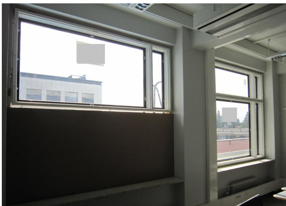
KUVA 8: 3.krs ikkunoita asennettuna, ennen eristystä ja viimeistelyitä (Kuva: Antti Niemi 2013)
