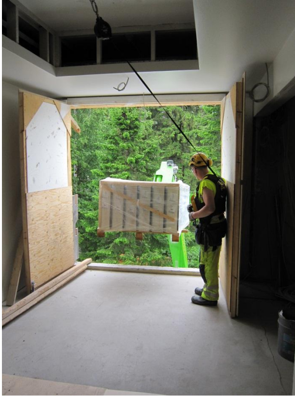
KUVA 5: Ikkunapaketti tulossa sisään nostoaukosta (Kuva: Antti Niemi 2013)
