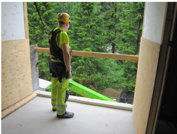
KUVA 4: Ikkunapaketin vastaanottoon valmistautumista nostoaukolla, turvaliivit kiinnitettynä valmiiksi ylös kiinnityspisteeseen (Kuva: Antti Niemi 2013)
