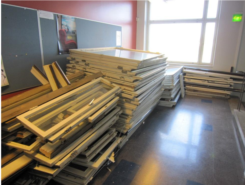
KUVA 7: Kerroksen puretut ikkunat valmiina rakennuksesta ulossiirtoon (Kuva: Antti Niemi 2013)
