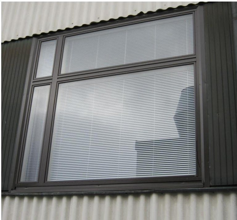
KUVA 2: Pellitys aikaisemmin vaihdetussa ikkunassa (Kuva: Antti Niemi 2013)
