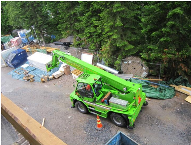
KUVA 3: Ikkunapaketin siirtoa kurottajalla (Kuva: Antti Niemi 2013)
