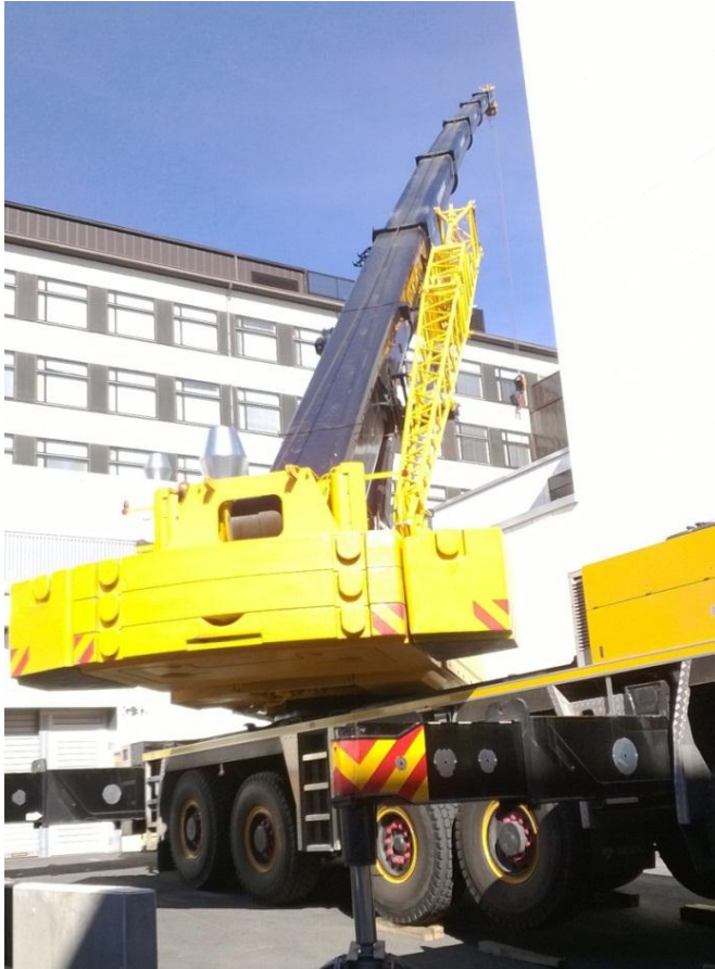
KUVA 9: Ikkunoita pellitetään nosturilla, riippukori nurkassa neljännen kerroksen ikkunoilla (Kuva: Antti Niemi 2013)
