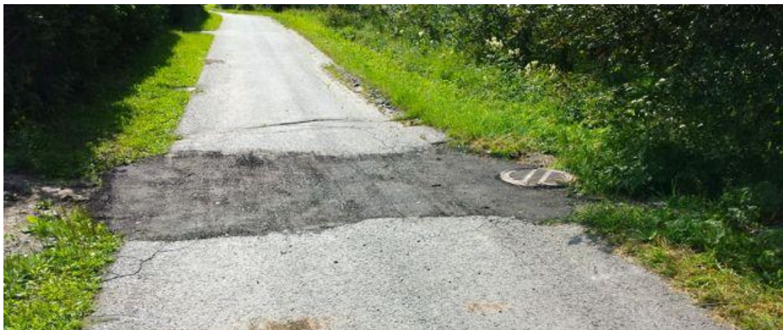
KUVA 8. Kaivulupakaivanto väliaikaisella päällysteellä
