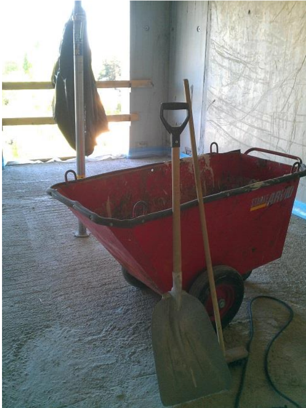
Kuva 4. Kerroksissa jätteet kerättiin työmaavaunuihin lapiolla ja harjalla. Sekajätteet kerättiin jätesäkkeihin.
