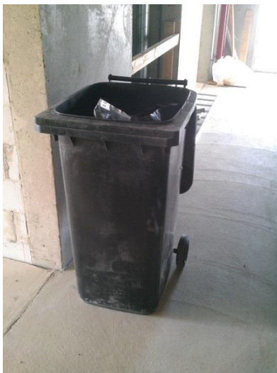
Kuva 3. Joka kerroksessa oli renkaalliset ja kannelliset jäteastiat, joihin kerättiin sekajätettä.
