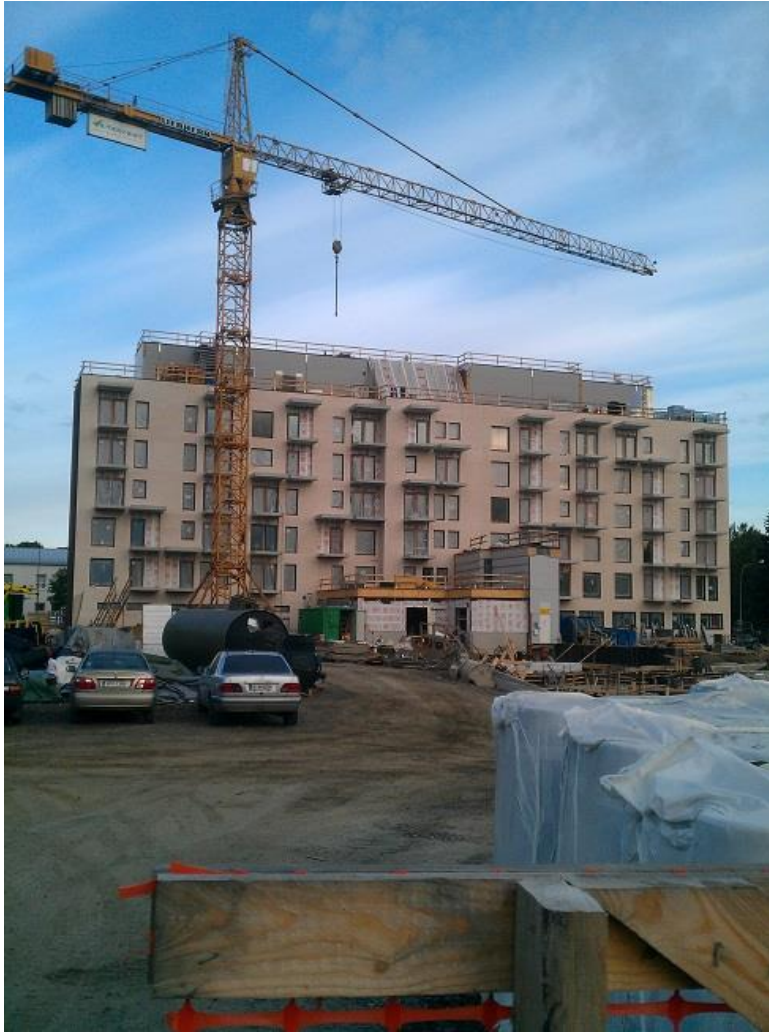
Kuva 1. Kuvassa on Asunto-osakeyhtiön Senioripihan 1. ja 2. vaiheen työmaa.
