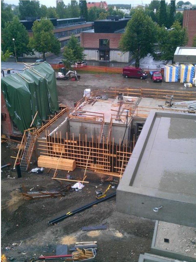
Kuva 5. Kuvassa on Senioripihan väestönsuojan paikallavaluseinämuottien valmistumista.
