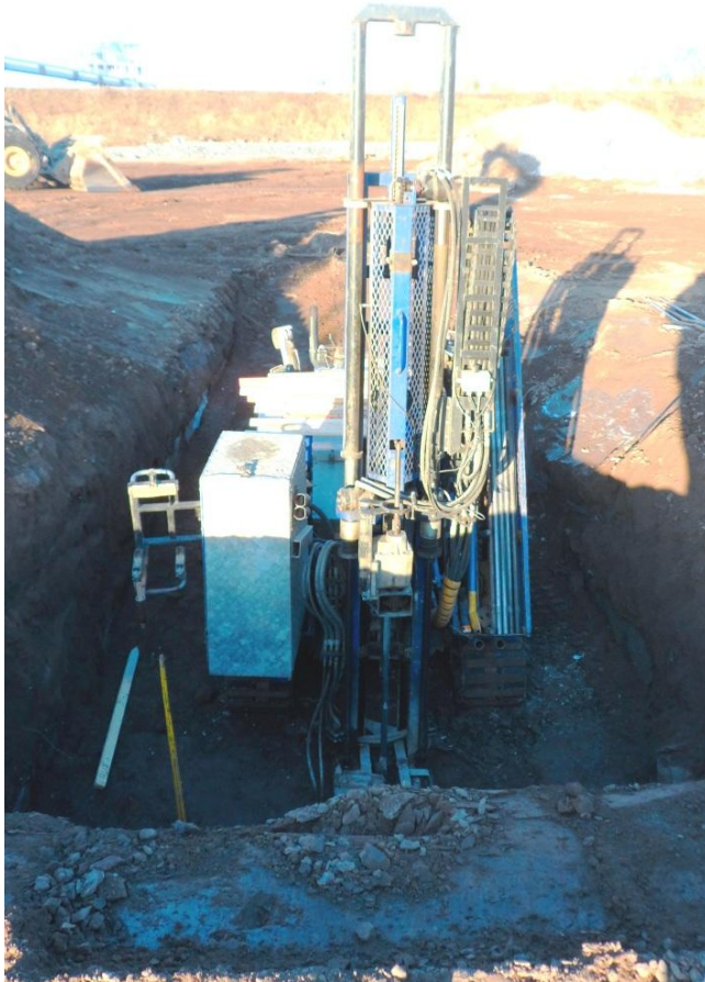
KUVA 7. Laadunvalvontakairaus aloitetaan stabiloinnin yläpinnasta.
