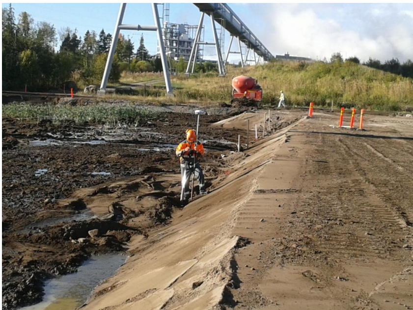
KUVA 15. Ruutujen kulmat merkattiin mittakepeillä.
