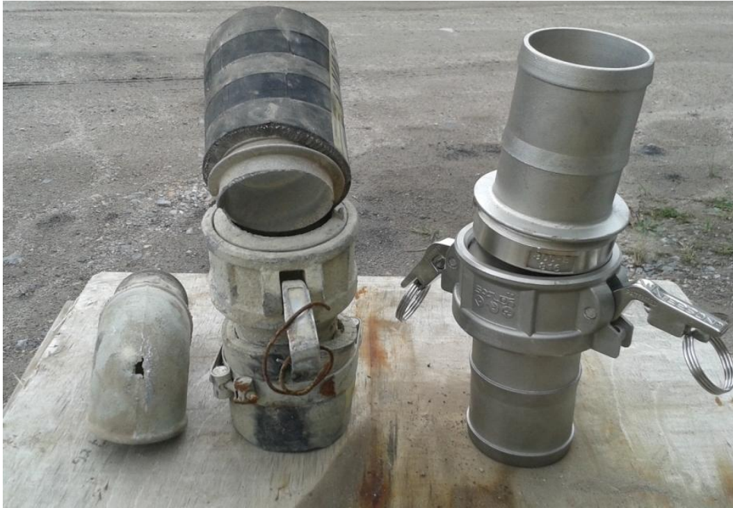
KUVA 17. Kuluneita ja uusia liittimiä.
