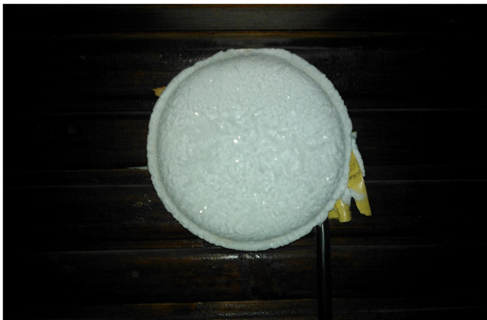
Kuva 9. Sisäilman sisältämä vesihöyry on tiivistynyt (kondensoitunut) kylmään raitisilmaventtiilin kanteen ja venttiilin riittävän alhaisesta lämpötilasta johtuen jäätynyt.
