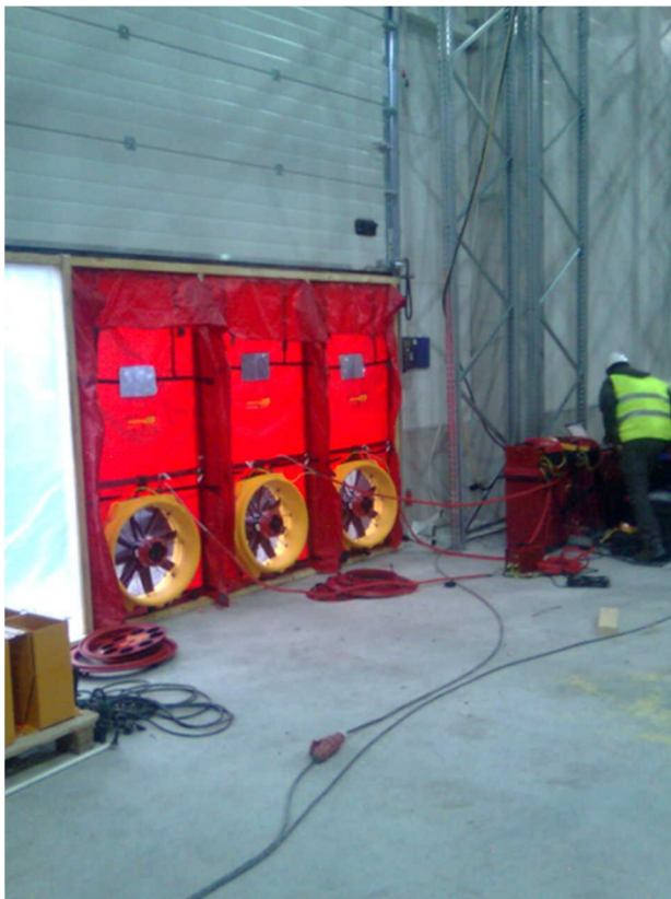
Kuva 22. Suuren rakennuksen tiivyyden mittaaminen.
