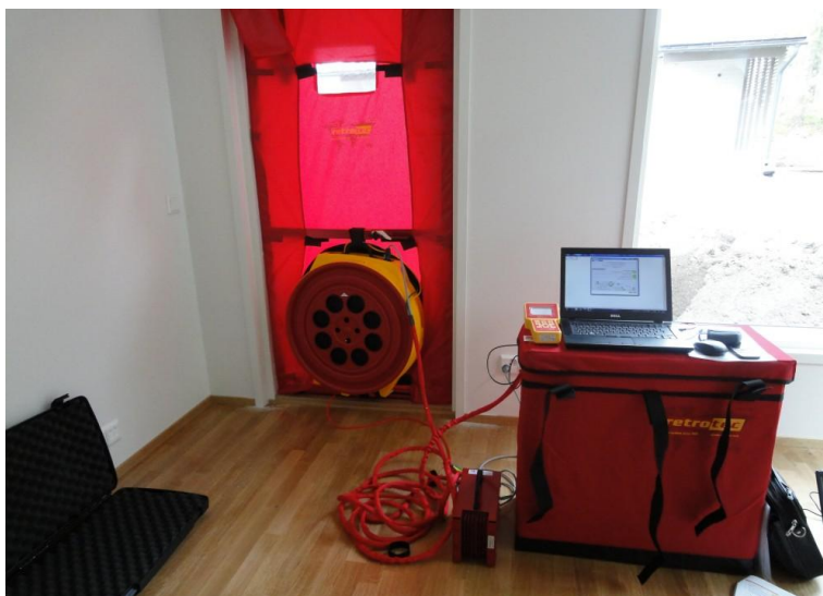
Kuva 14. Tiiviysmittauslaitteisto asennettuna rakennuksen ulko-oveen.
