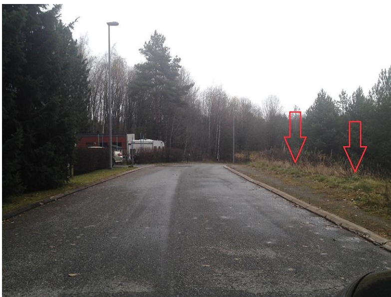
Kuva 30. Plassinkadun poikkileikkaus (nuolet osoittavat lumitilaa).
