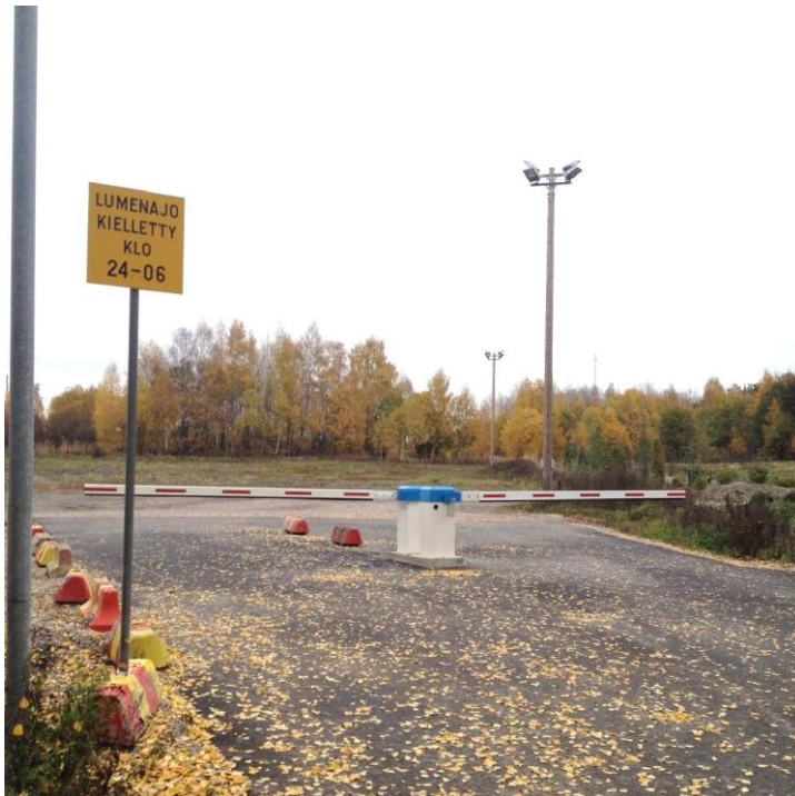
Kuva 17. Iso-Heikkilän lumenvastaanottoaikan kulunvalvontaportit.
