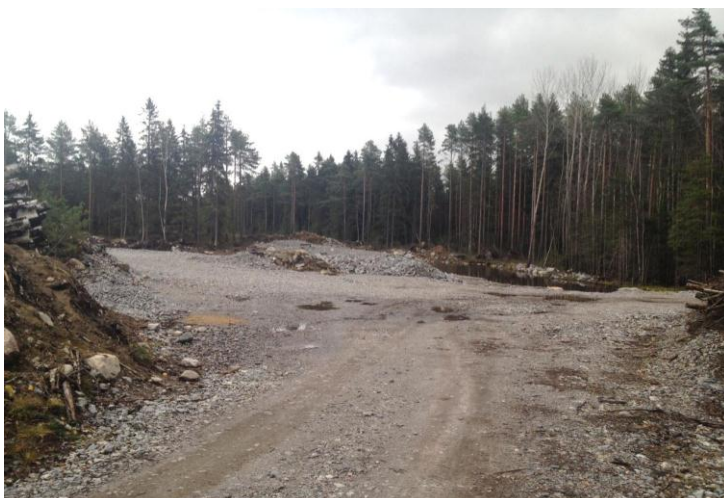
Kuva 20. Uuden asuinalueen rakennustyömaa.
