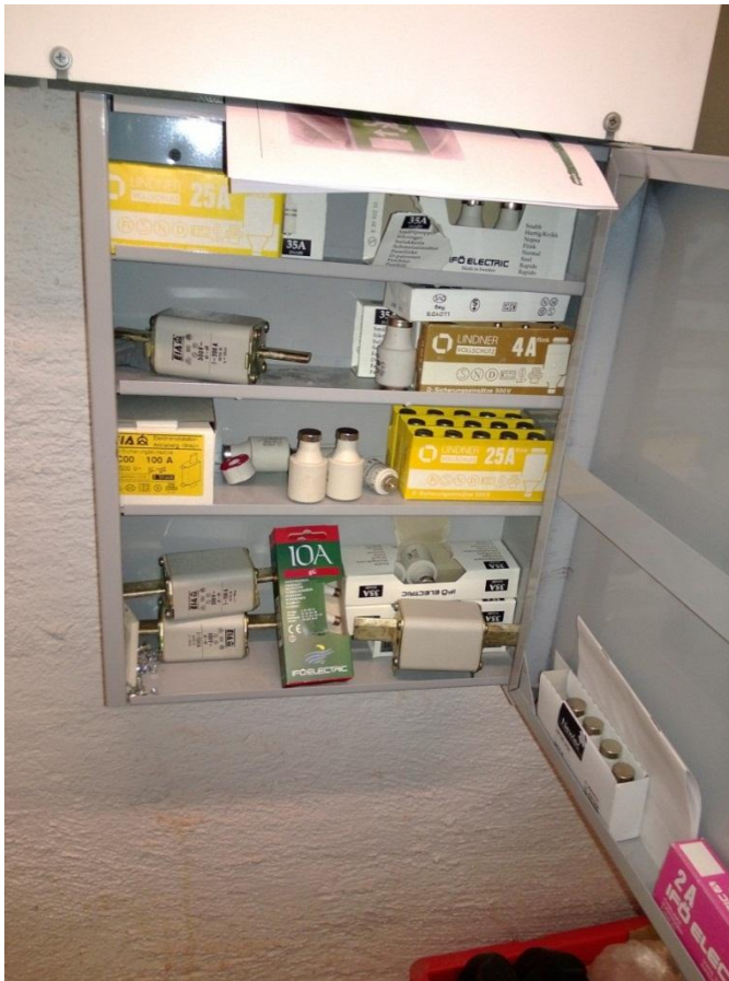
KUVA 6. Hyvin varusteltu pääkeskus, jossa tarvittavat varuslaksheet (Valokuva Sami Linnoaho)
