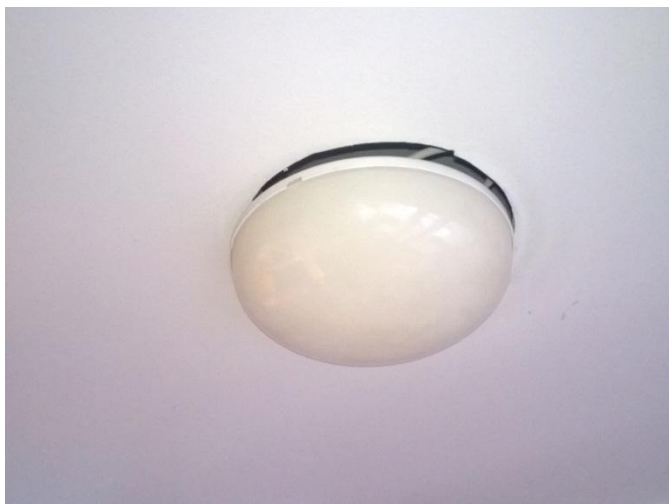
KUVA 12. Kerhotilan eteisen valaisin irti katosta (Valokuva Sami Linnoaho)
