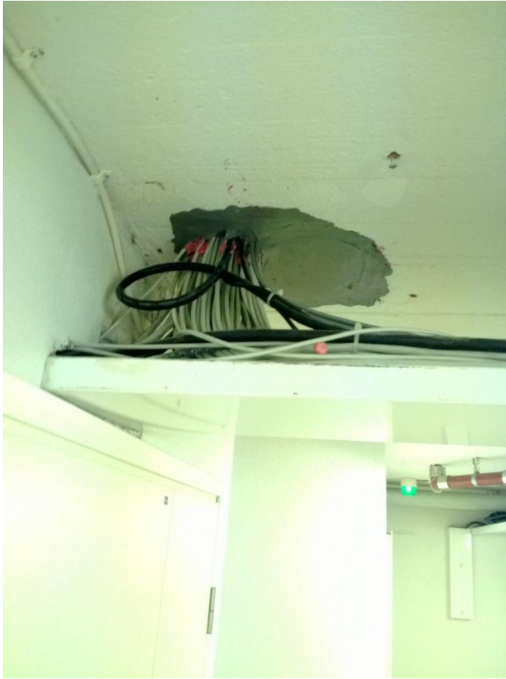
KUVA 2. Läpiviennin ja asennusreitit tarkastelu (Valokuva Sami Linnoaho)
