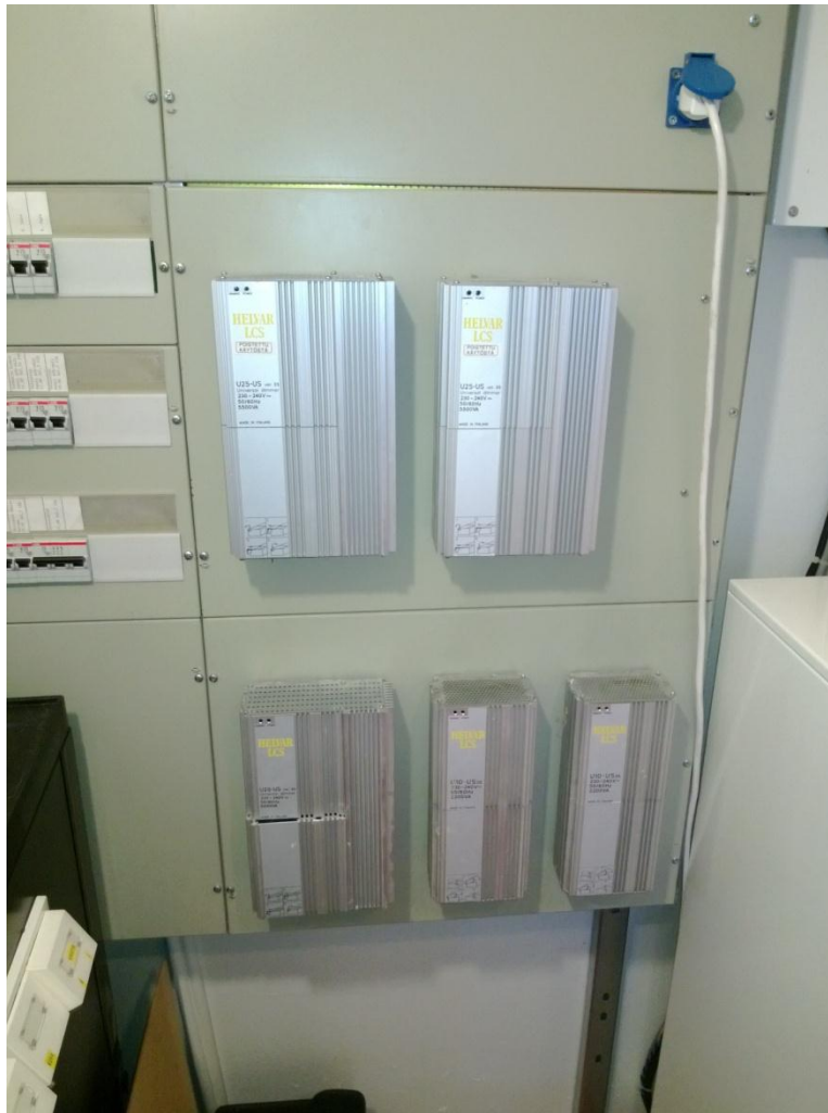
KUVA 7. Jakokeskus, JK 13, alarivin vasemmanpuoleisen säätimen kansi irti (Valokuva Sami Linnoaho)
