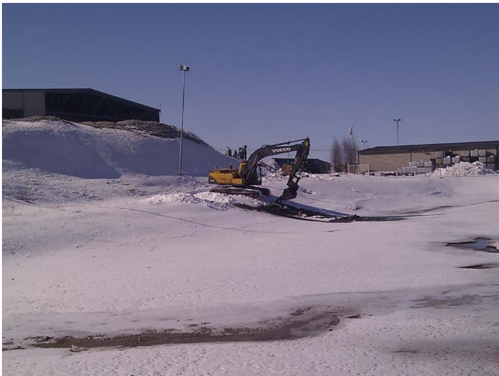
Kuva 2. Näytteenotto 1: Maanäytteen kaivuu käynnissä (Tuhola 2013)
