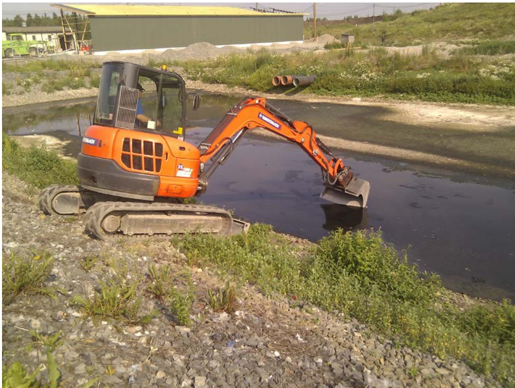
Kuva 5. Näytteiden kaivuu käynnissä (Tuhola, 2013)
