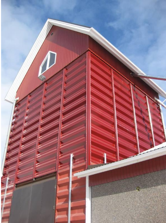
KUVIO 5. Kunnostettu ja laajennettu kuivuri.
