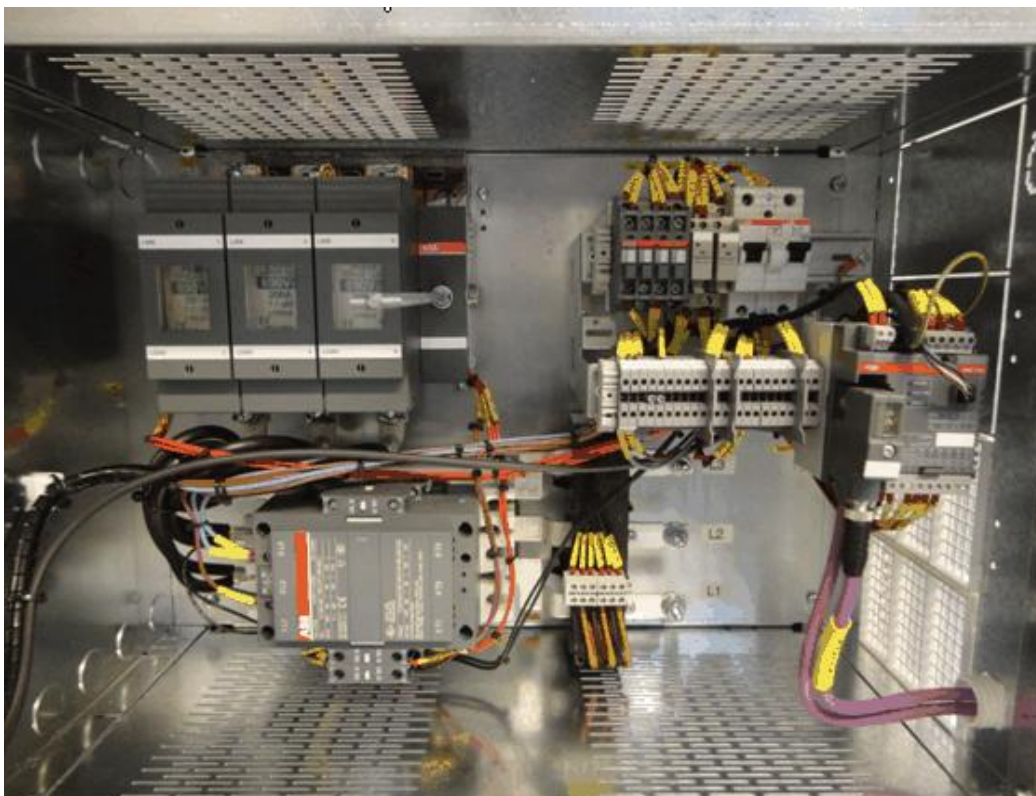
Kuva 4. Kytkinvarokesyötöllä toteutettu moottorilähtö
