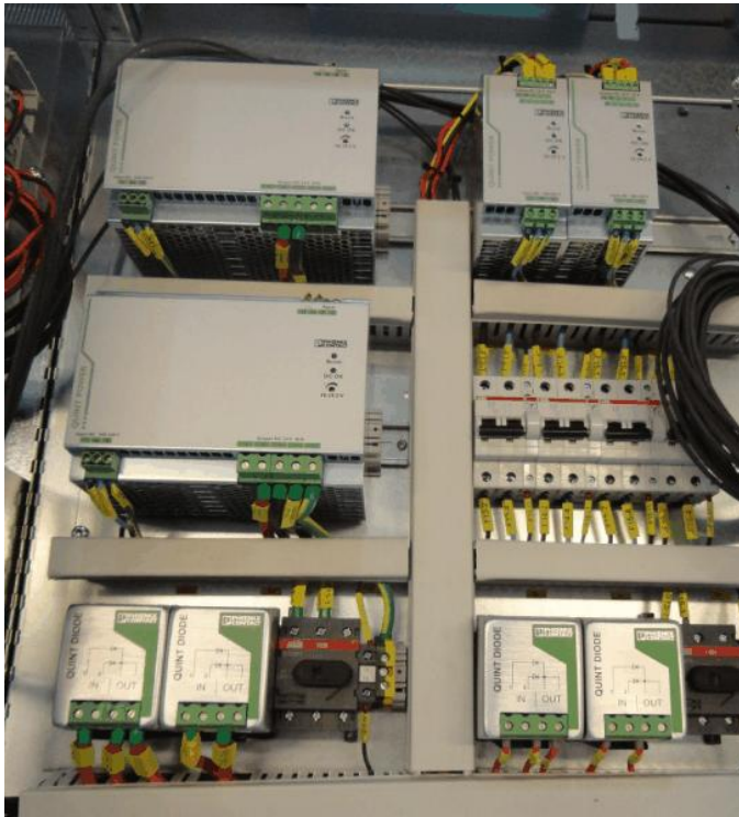
Kuva 78. Rinnankytketyt virtalähteet.
