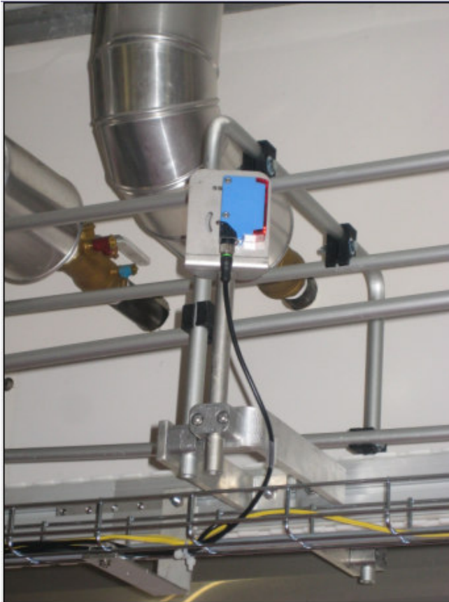
Kuva 1. Peilistä heijastava SICK – valokenno.
