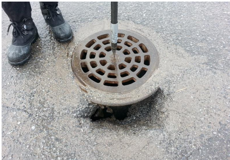
Kuva 40. Maa on painunut viettolinjan yläpuolelta. Kuva: M. Saarikangas.
