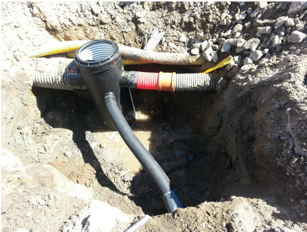
Kuva 36. Vedenjohtamisen kannalta toimiva ratkaisu. Kuva: M. Saarikangas.
