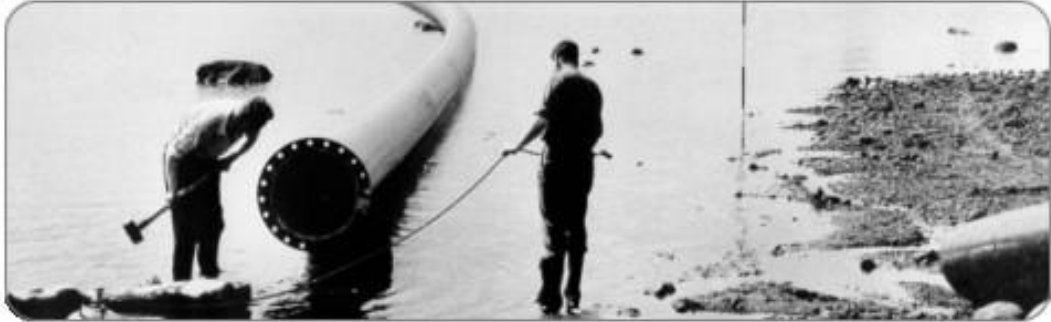
Kuva 5. Putken asennusta ennen vanhaan. /23/
