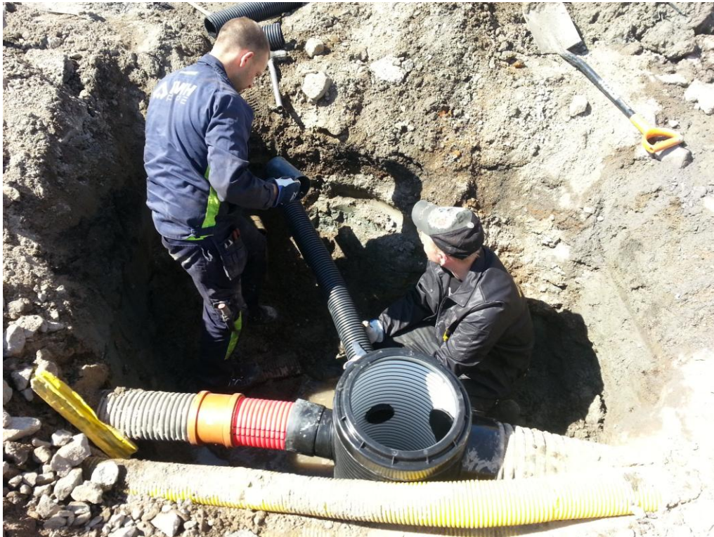
Kuva 35. Uuden kaivon ja liittymien asennusta. Kuva: M. Saarikangas.
