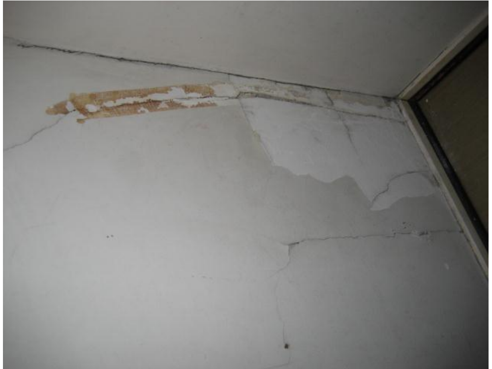
Kuvio 4 kylpyhuoneen ja olohuoneen välinen seinä ennen linja-saneerauksen aloitusta, kuva otettu huoneiston ennakkokatselmuksessa. As Oy Satakallio vaihe 1 työmaalta.
