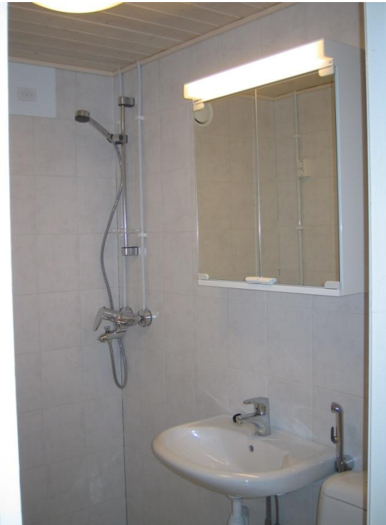
Kuvio 10 Malliasennus, joka tehtiin talon ensimmäisen linjan ylimpään asuntoon, jonka laatutaso määrittä kaikki muiden asuntojen laatutason. As Oy Satakallio vaihe 3 työmaalta.
