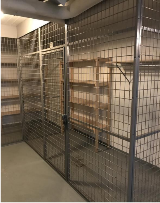
Kuva 7. Varuskunnankodon uudelleenkäytettäviin rakennusosiin luetteloitiin mm. verkkokellarikomerojen metallirakenteet (Cedcon Oy, 2020).
