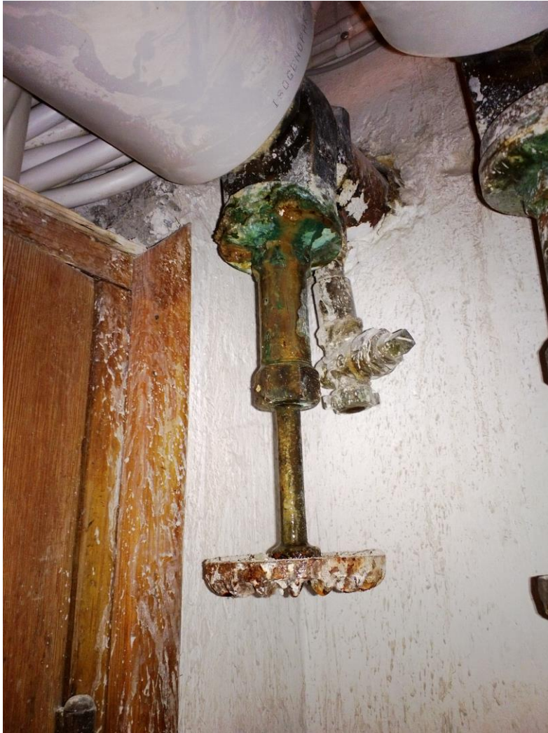
Kuva 4. Vanha sulkuventtiili lämpöjohtoverkostossa.
