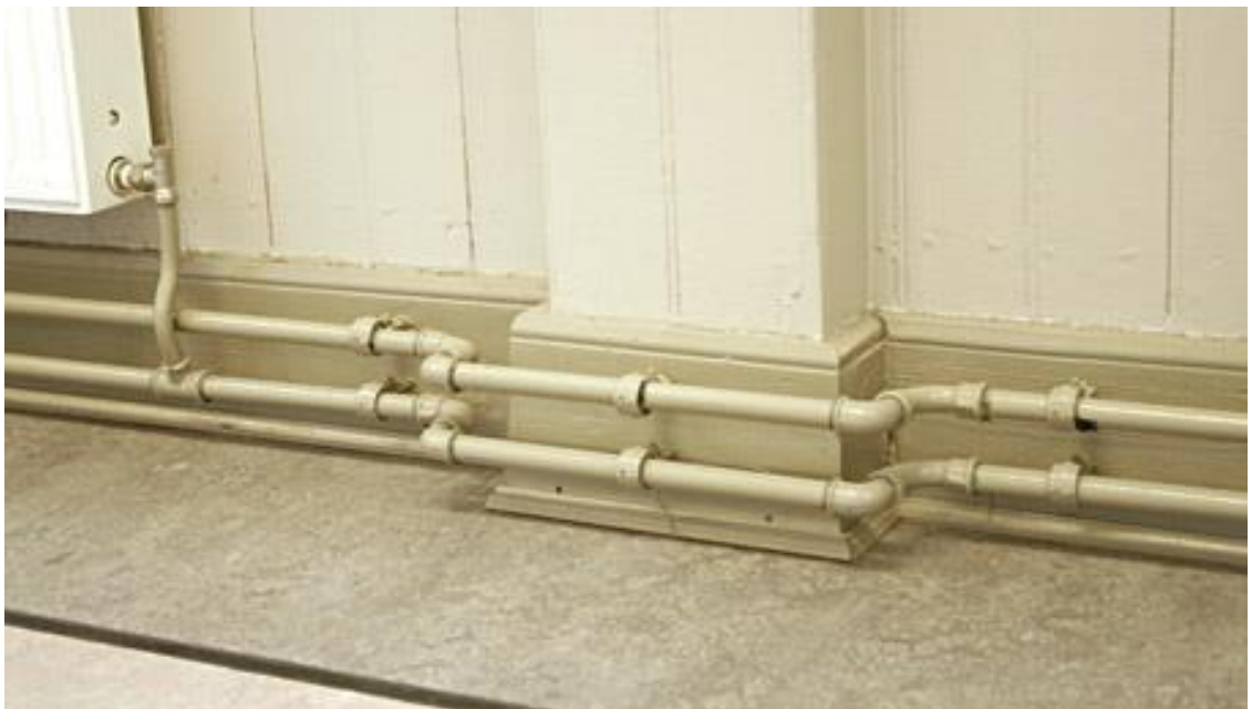
Kuva 7. Kierreosista tehtyjä teräsputkia lämpöjohtoina.
