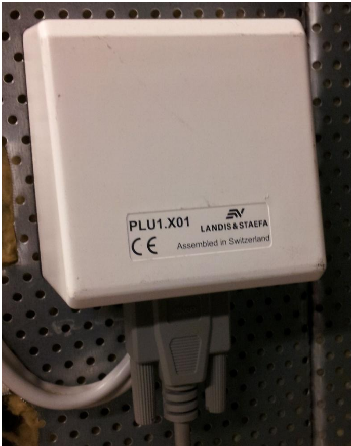
KUVA 13. Väyläliityntäkotelo PLU.X01
