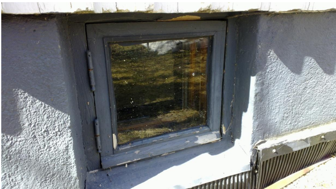
KUVA 6: Kellarin ikkuna (Kuva: Jaakko Huttunen 2012)
