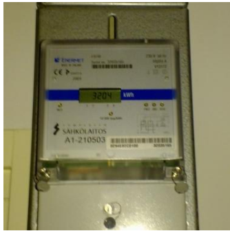
KUVA 27: Yläkerran sulaketaulu (Kuva: Jaakko Huttunen 2012)
