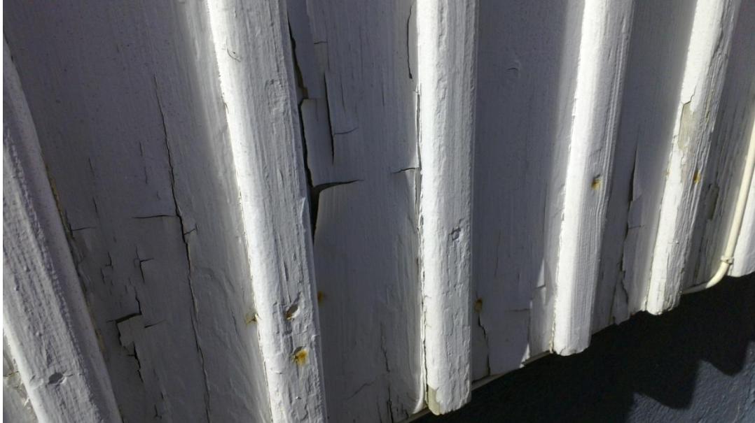
KUVA 4: Ulkoverhous (Kuva: Jaakko Huttunen 2012)
