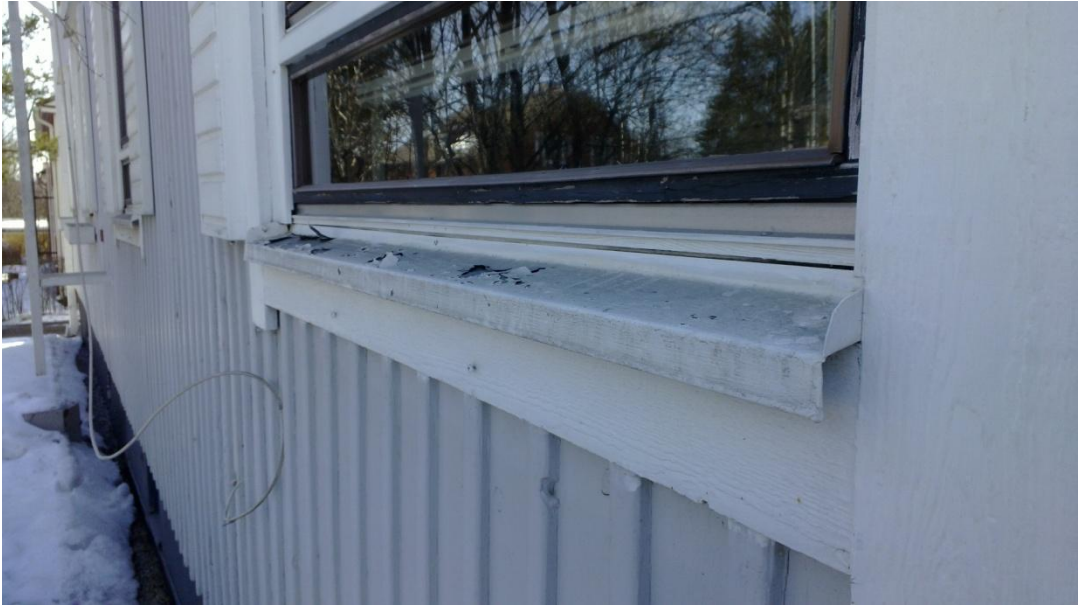
KUVA 5: Ikkunapelti (Kuva: Jaakko Huttunen 2012)
