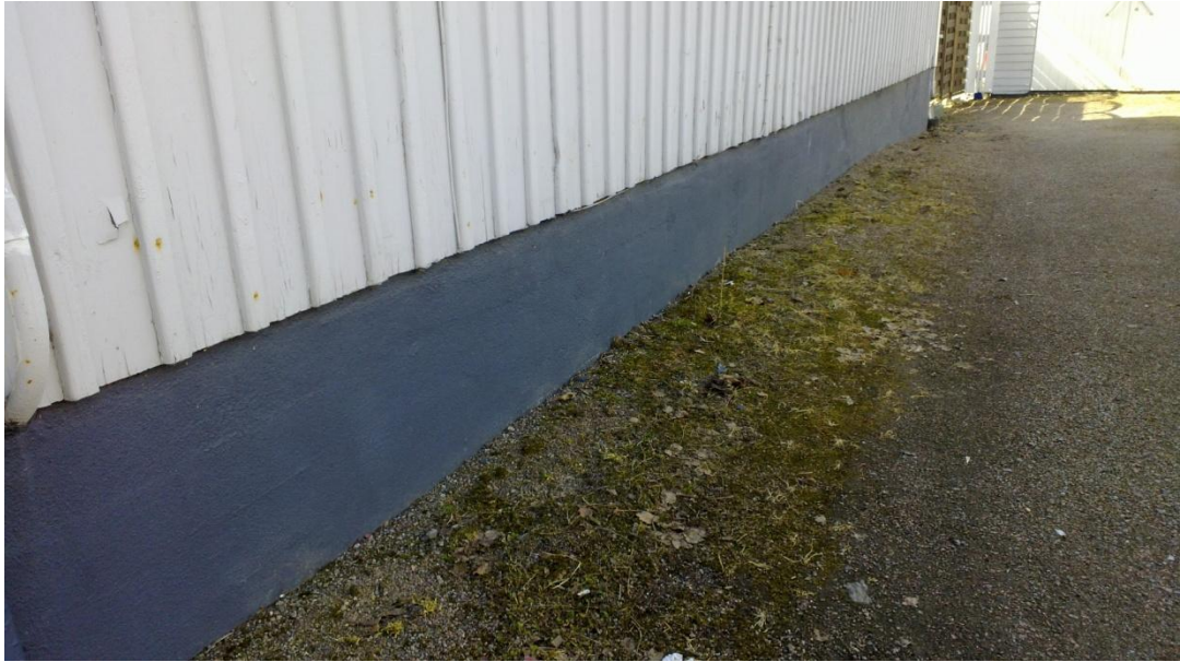
KUVA 2: Pohjoispäädyn sokkeli (Kuva: Jaakko Huttunen 2012)
