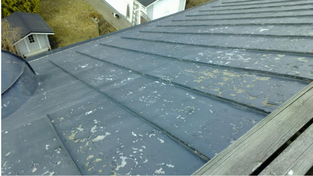
KUVA 8: Vesikatto (Kuva: Jaakko Huttunen 2012)
