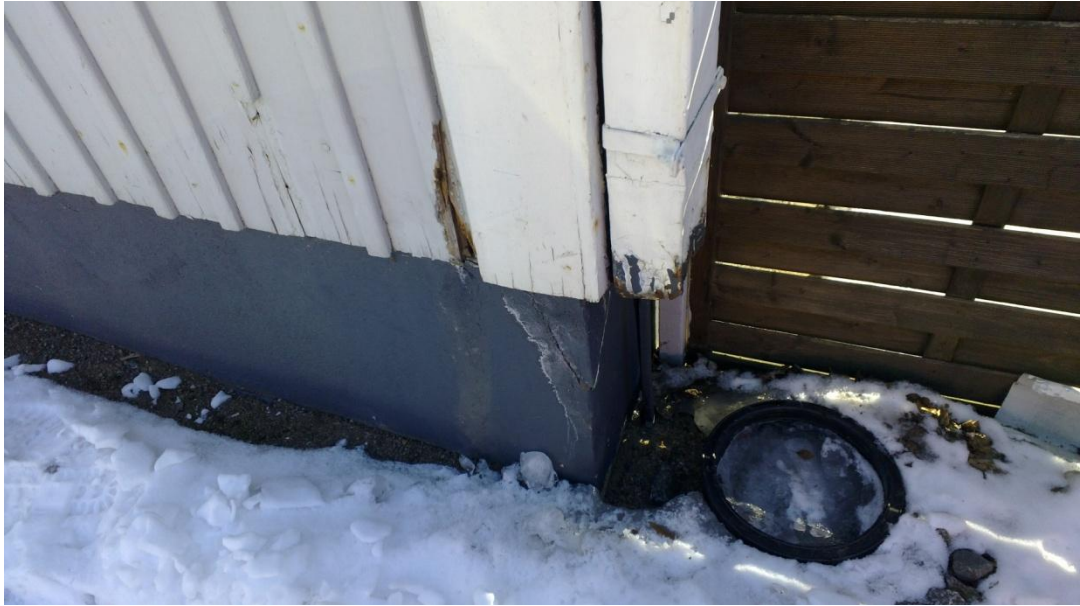
KUVA 3: Syöksytorvi ja sadevesikaivo (Kuva: Jaakko Huttunen 2012)
