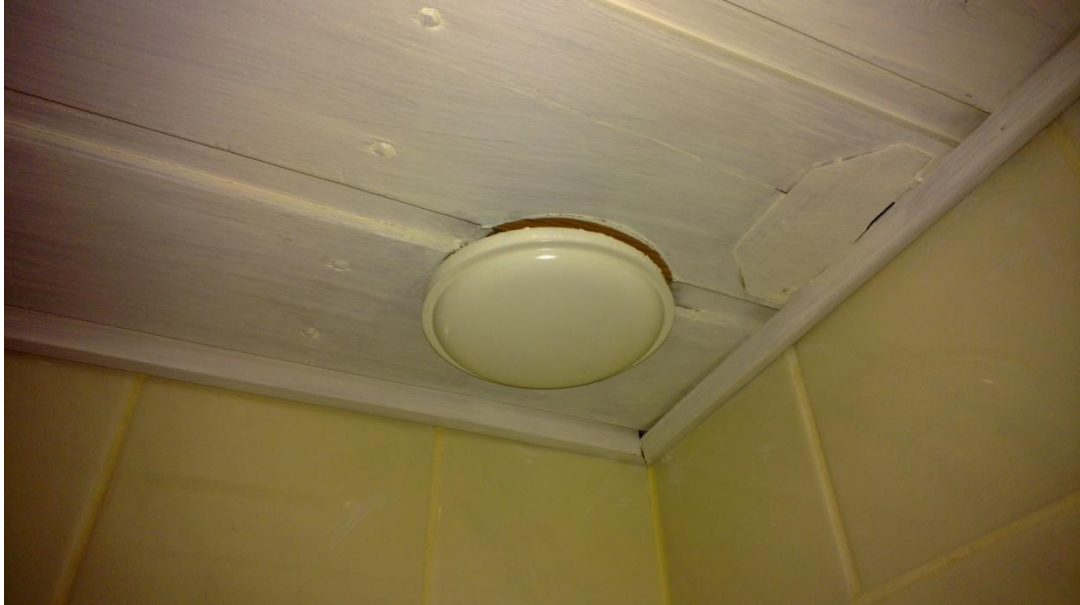
KUVA 22: WC:n painovoimainen ilmanvaihtoventtiili (Kuva: Jaakko Huttunen 2012)
