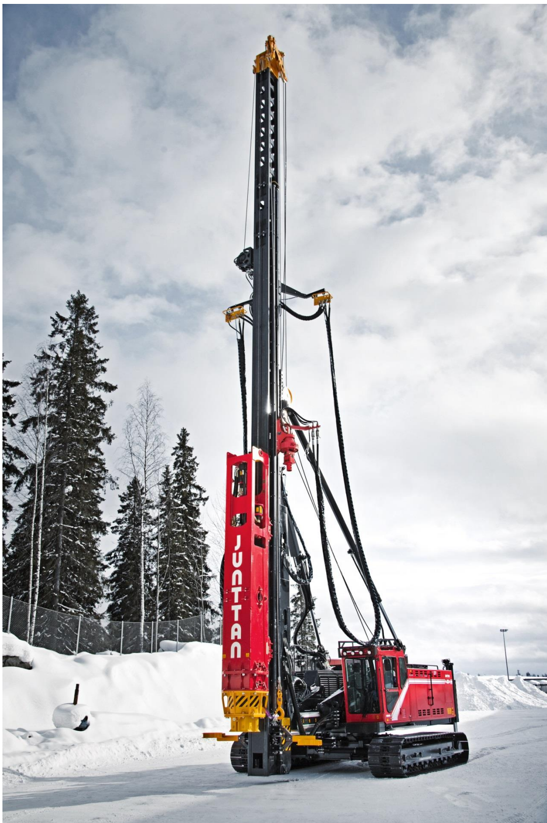
KUVA 1. Junttan PMx20 koeajossa Kylmämäen tehtaalla (Junttan kuva-arkisto 2013.)
