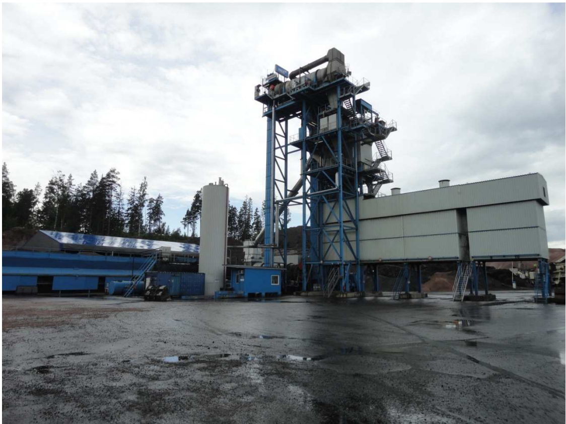
Kuva 1. Voutilan asfalttiasema Vantaalla. (Kuva: Juha Hirvonen)
