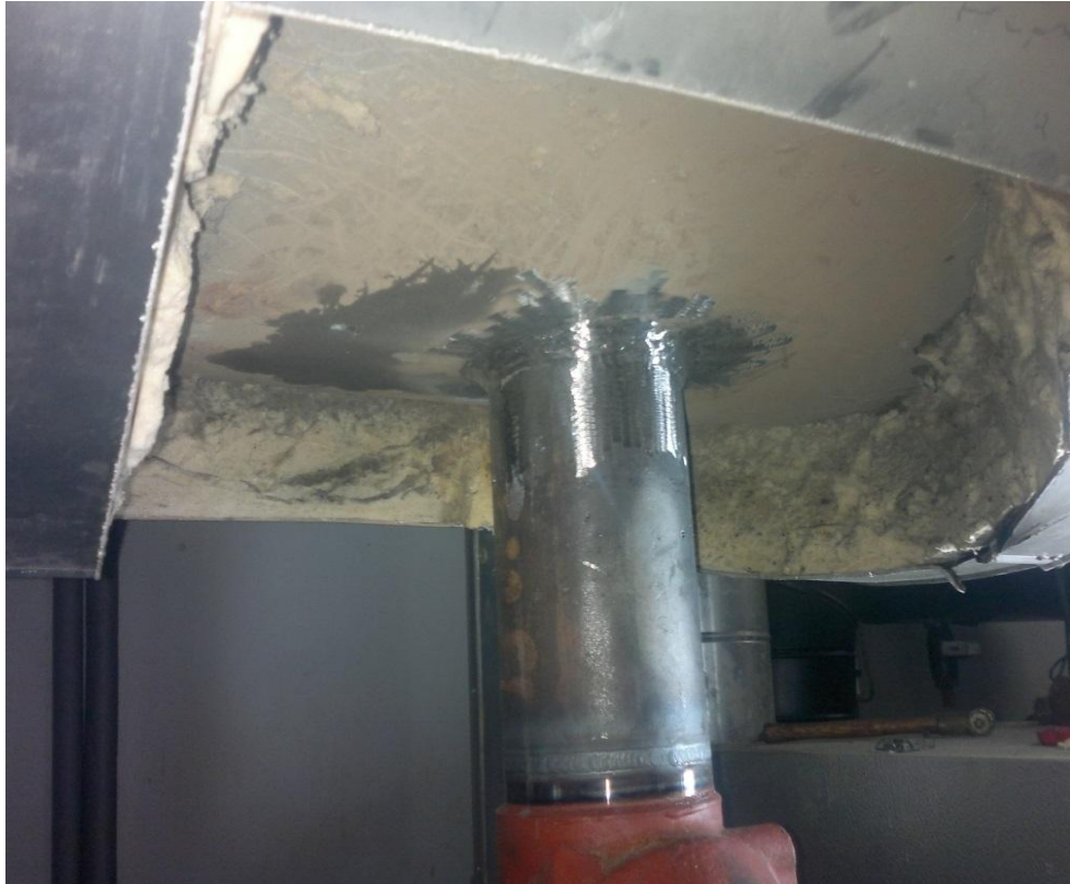
KUVA 13. Pisaranerottimen ja nesteputkiyhteen kiinnitys
