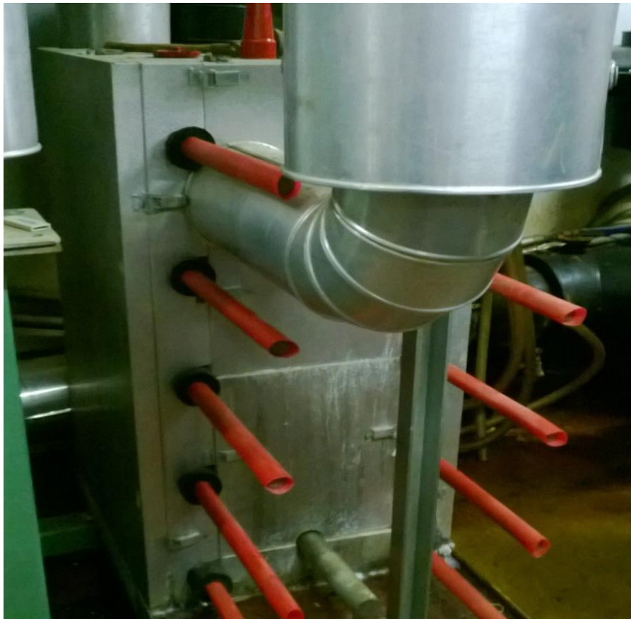
KUVA 6. Jäähallin kylmäprosessin höyrystinyksikkö
