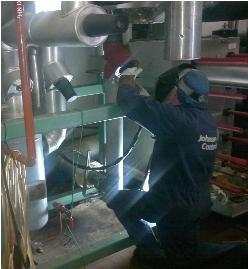
KUVA 11. Nesteputken ja venttiilin kiinnitys sekä hitsaustyövaihe
