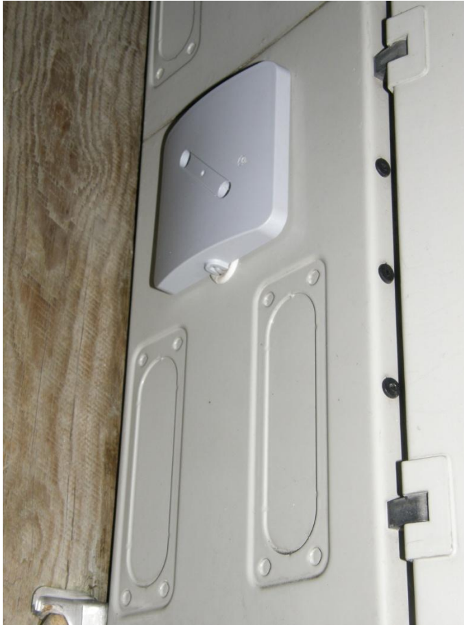
KUVA 2. Antenni asennettuna keskuksen ulkopintaan
