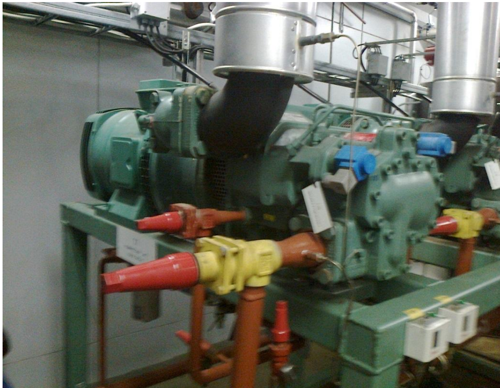
KUVA 3. Jäähallin kylmäprosessin kompressori JK1
