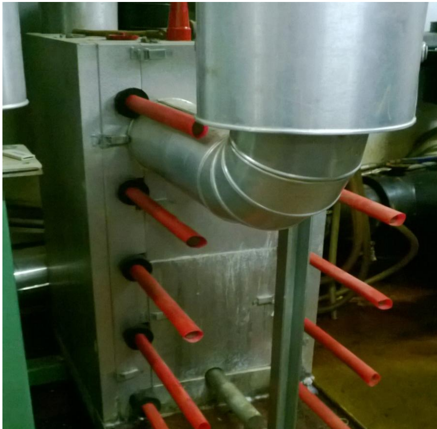
KUVA 6. Jäähallin kylmäprosessin höyrystinyksikkö
