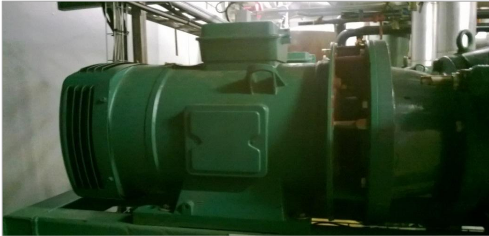
KUVA 15. Vanha sähkömoottori, oikosulkumoottori Leroy Somer
