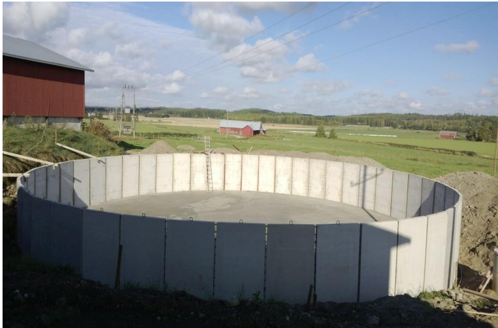
Kuva 2. Malmiharju, P- Haukkalan tilan 1200 kuution lietesäiliön rakennusvaiheen kuva. Kesä 2013.
