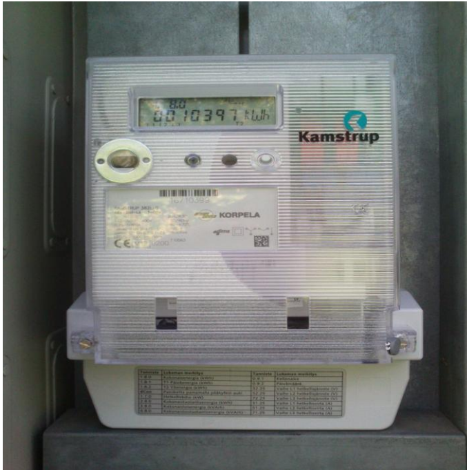
Kuva 2. Etäluettava sähkömittari Kamstrup
