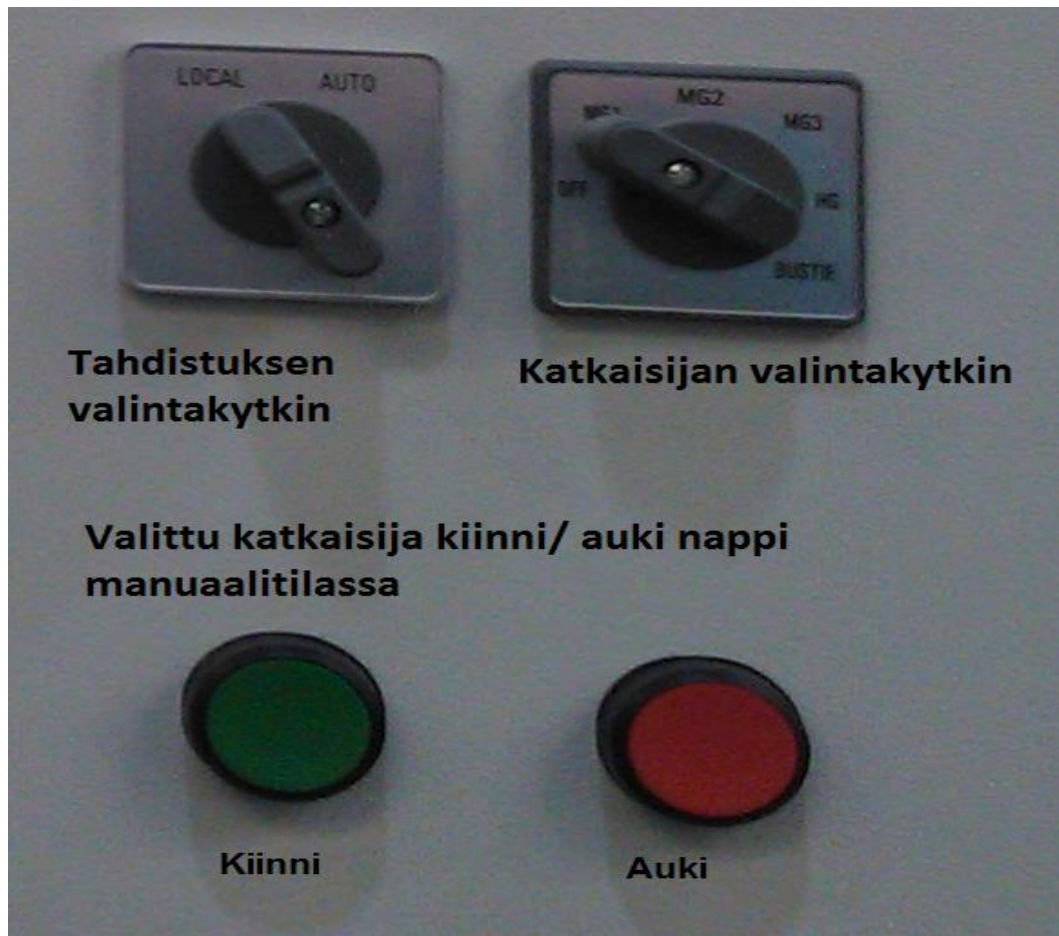
Kuva 6. Katkaisijan ja ohjauksen valinta tahdistuksessa.
