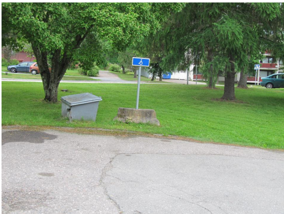
Kuva 13. Tervakosken terveysaseman puutteellisesti merkitty LE-paikka
