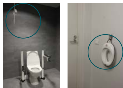
KUVA 31. Hätkäksuvedin liian korkealla ja piilotettuna pottaistuimen taakse Suomessa (Nenonen 2013)
