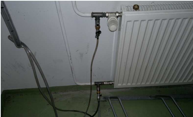
Kuva 8. Vesimanometri kytkettynä patterille asennetuille yhteille
