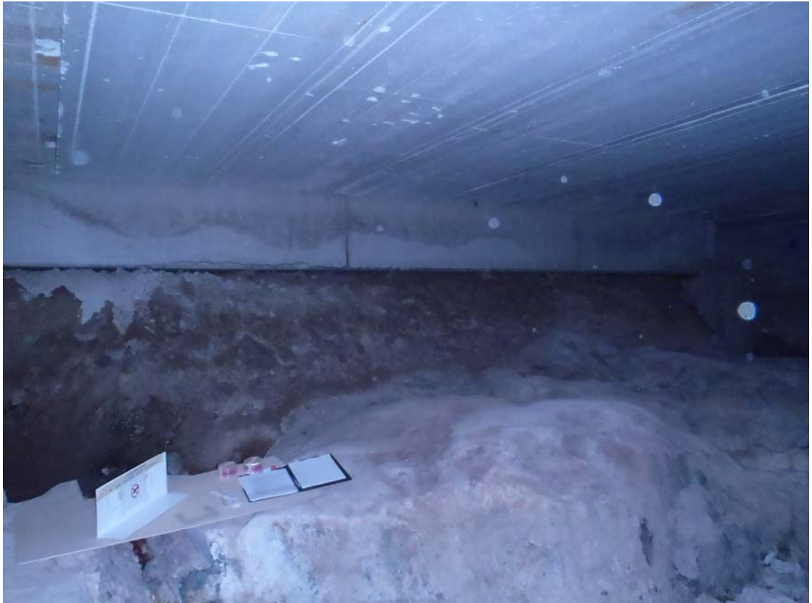
Kuva 9. Kohde B:n ryömintätilassa on laajalti kalliopintaa näkyvissä.
