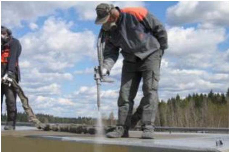
Kuva 6. Nestemäisenä levitettävän eristyksen tekoa (SILKO 1.801 2011, 1.)
