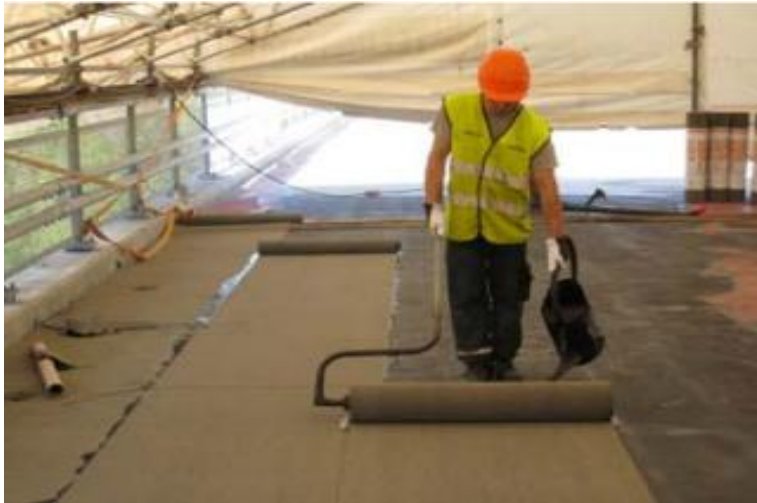
Kuva 4. Kermieristysten tekoa liimaamalla (SILKO 1.801 2011, 24.)
