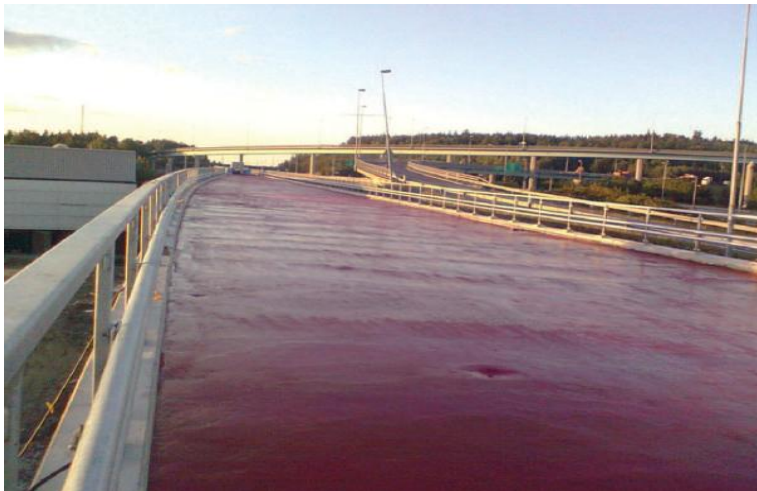
Kuva 3. Eristysalustan päälle levitetty epoksitiivistys (Iho 2012.)
