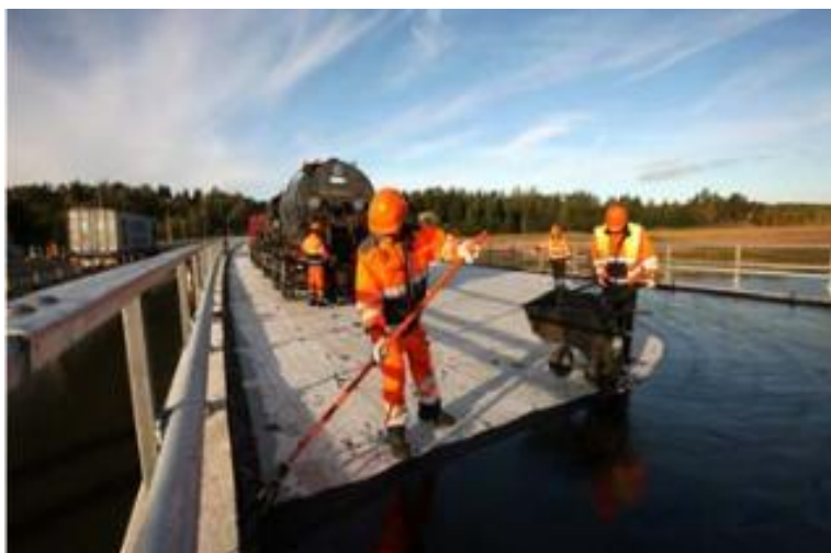
Kuva 5. Kumibitumimastiksieristysten tekoa (SILKO 1.801 2011, 1.)
