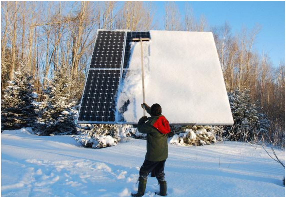
Kuva 16. Aurinkopaneeleja joudutaan puhdistamaan lumesta latauksen parantamiseksi.
