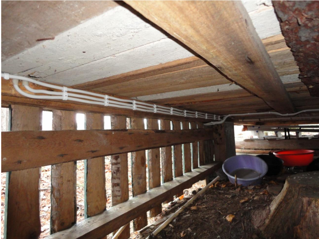
Kuva 5. Kesämökin alle asennettuja kaapeleita.
