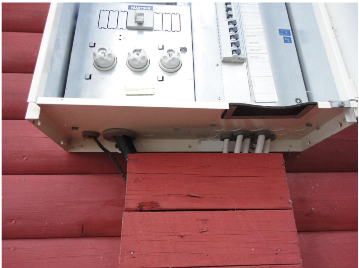
Kuva 4. Keskuksen kaapelointeja.
