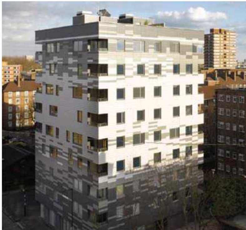
Kuva 1. Lontoon 9-kerroksinen puukerrostalo [15].
