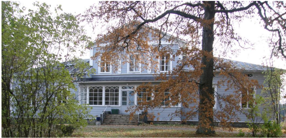
KUVA 1 Sairaala-alueen vanhin rakennus 1800-luvulta
