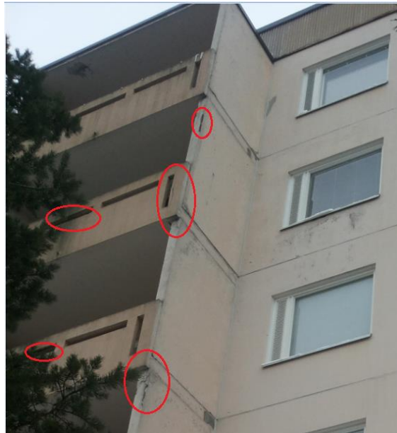
Bild 14 Närmare bild av skadorna på balkonerna. Man ser sprickor i räcken och bitar av betong som lossnar i hörnen och synlig armering. Räckena har dessutom börjat lossna från sidoväggarna. Sprickor i sidoväggarna. Färg har också lossnat och man ser lappningar som gjorts tidigare.
