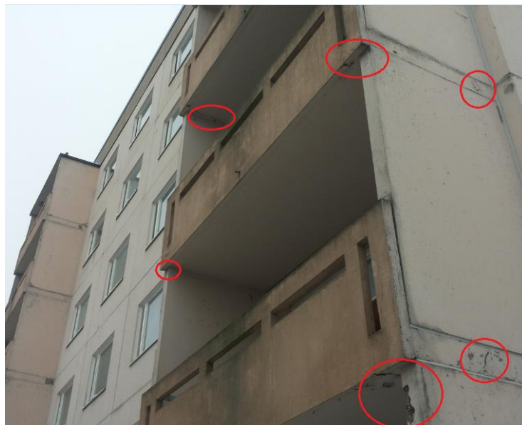
Bild 14 Närmare bild av skadorna på balkonerna. Man ser sprickor i räcken och bitar av betong som lossnar i hörnen och synlig armering. Räckena har dessutom börjat lossna från sidoväggarna. Sprickor i sidoväggarna. Färg har också lossnat och man ser lappningar som gjorts tidigare.
