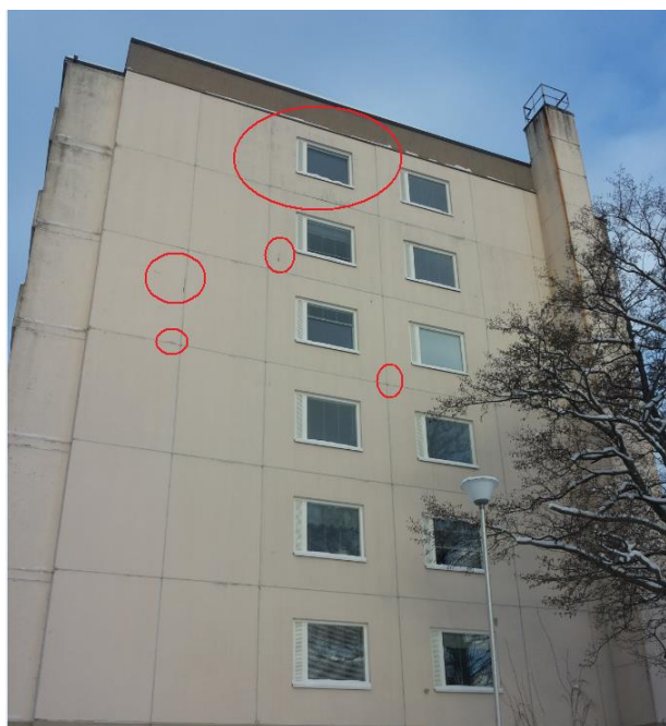
Figur 4. Mindre sprickor och bortfallna delar av elementen södra fasaden av TALO A. På sjätte våningen ser man början till frostvittring © Andreas Pettersson. (bilaga 1)
