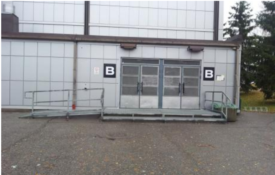
KUVA 37. Jäähallin esteetön B-sisääkäynti. Valokuva Jasmin Vartiainen 2013
