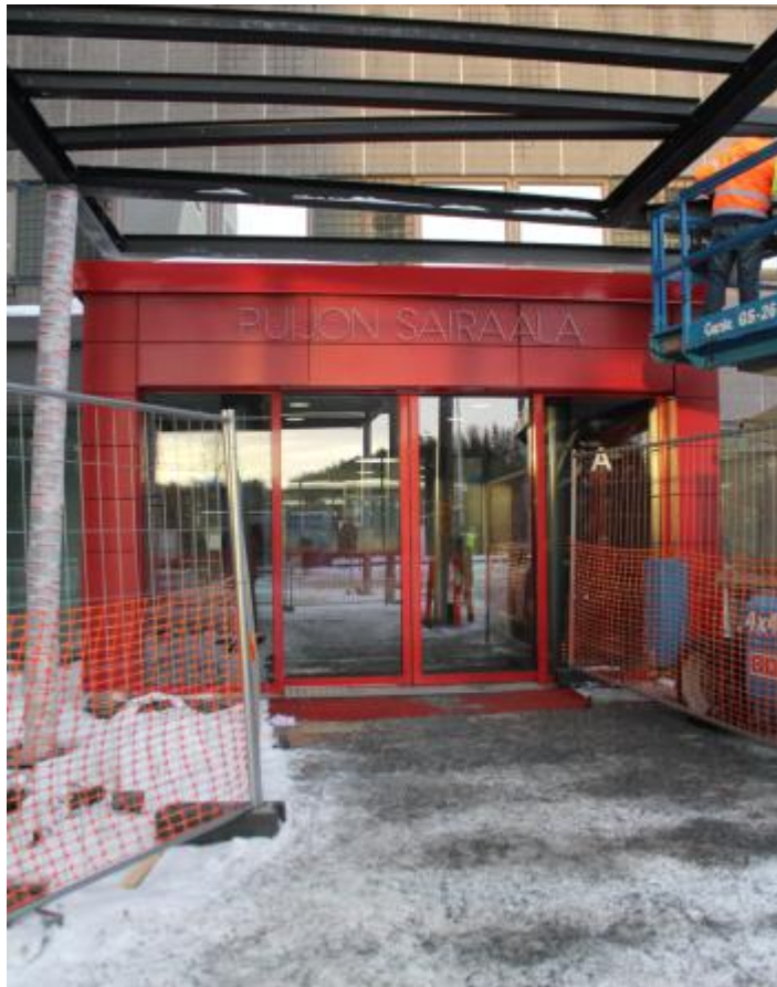
KUVA 19. Puijon sairaalan remontissa oleva pääsisäänkäynti.
