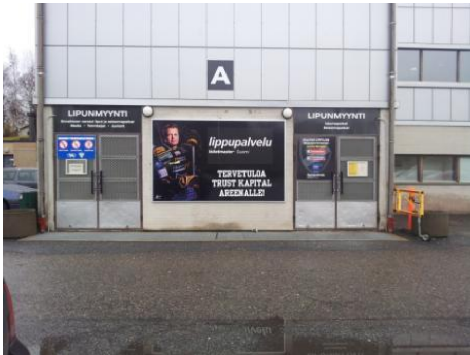
KUVA 36. Niiralan jäähallin A-sisäänkäynti. Valokuva Jasmin Vartiainen 2013
