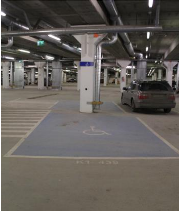
Kuva 60. Liikkumisesteisille varattujen pysäköintipaikkojen merkintä torin alla sijaitsevassa pysäköintihallissa.
