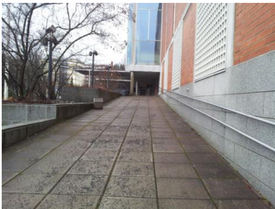
KUVA 43. Musiikkikeskuksen pääsisäänkäynnille johtava luiska.
