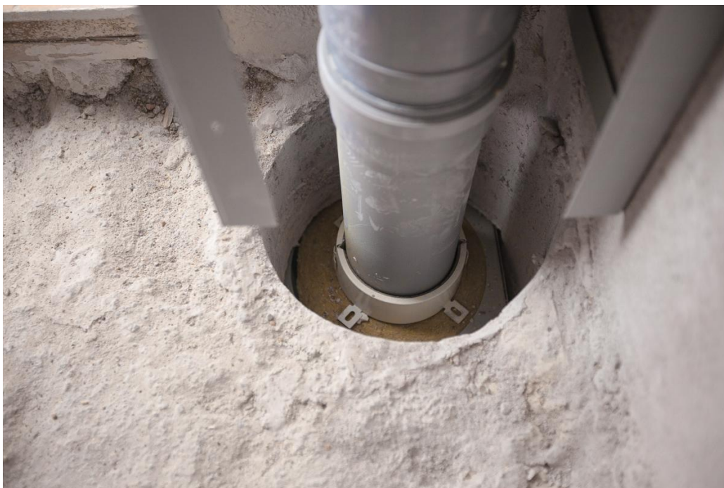
Kuva 12. Timanttiporalla välipohjaan tehty reikä pystyviemärielementille pesuhuoneessa
