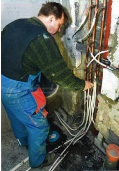
Kuva 4. Perinteinen linjasaneeraus, rakenteiden avaus ja putkien uusiminen entisille paikoilleen
