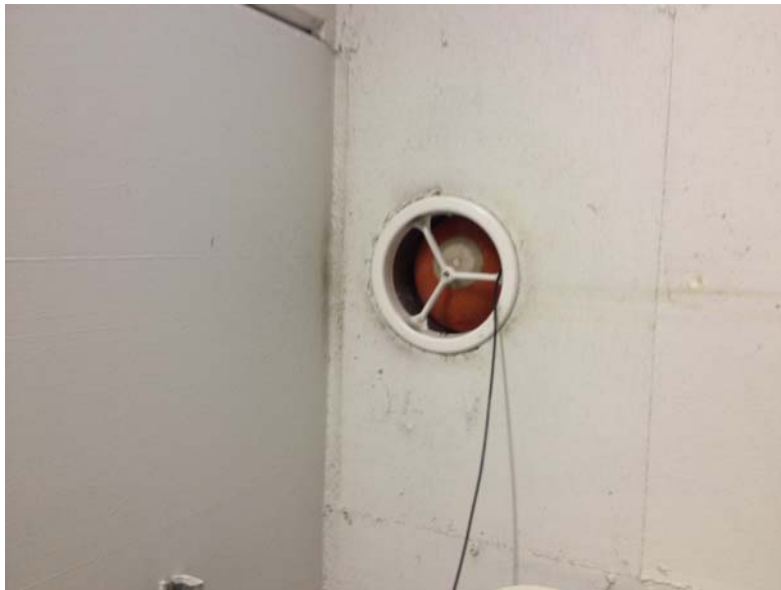
Esimerkkikuva, kellaritilan raitisilmakanavan tulppaus
