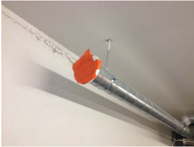
Esimerkkikuva, poistoilmaventtiilin teippaus
