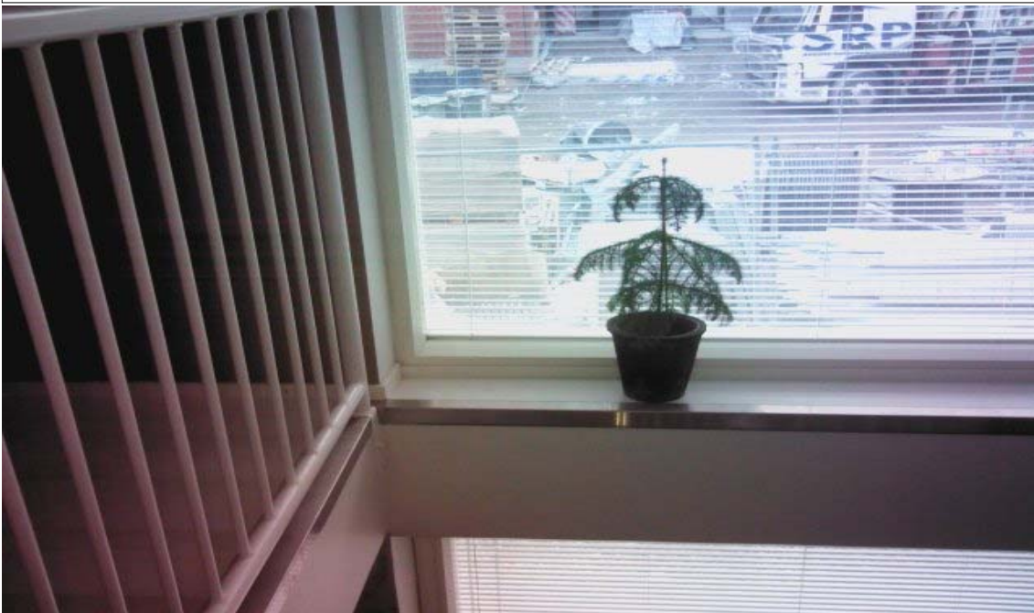
Kiinteä ikkuna, lievä ilmavuoto karmin ja lattian, sekä ikkunan ja karmin välistä
