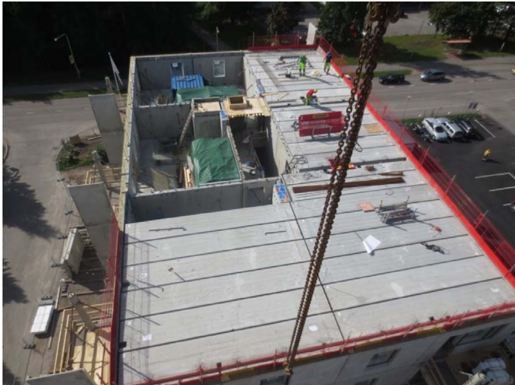
Kuva 10. Hollolan Hannan viidennen kerroksen kylpyhuone-elementit on asennettu ja suojattu. Yläpohjan ontelolaatta-asennus on meneillään. (Kuva: Petja Syrjäläinen 2013)
