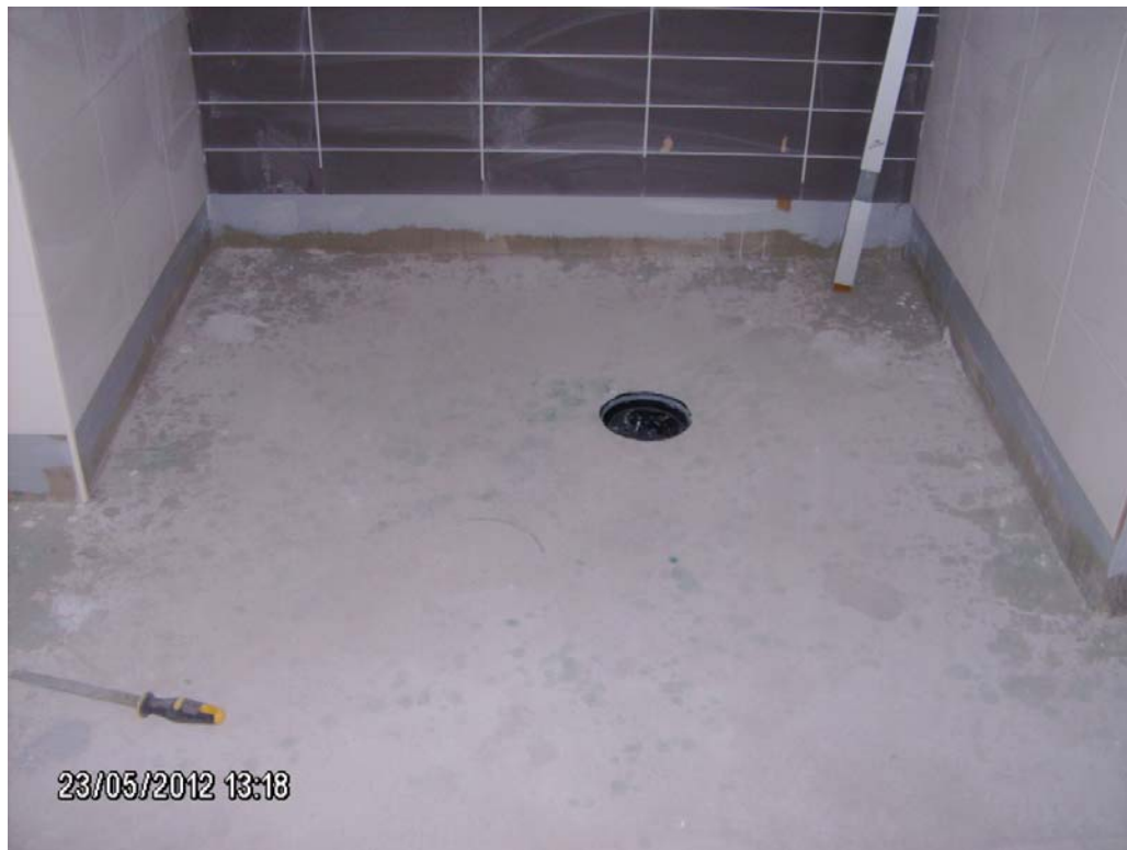
Kuva 14. Kylpyhuoneosaston seinät laatoitettu ja saumattu. Kuva on NCC:n aiemmasta kohteesta vuodelta 2012. (Kuva: Matti Luostarinen 2012)
