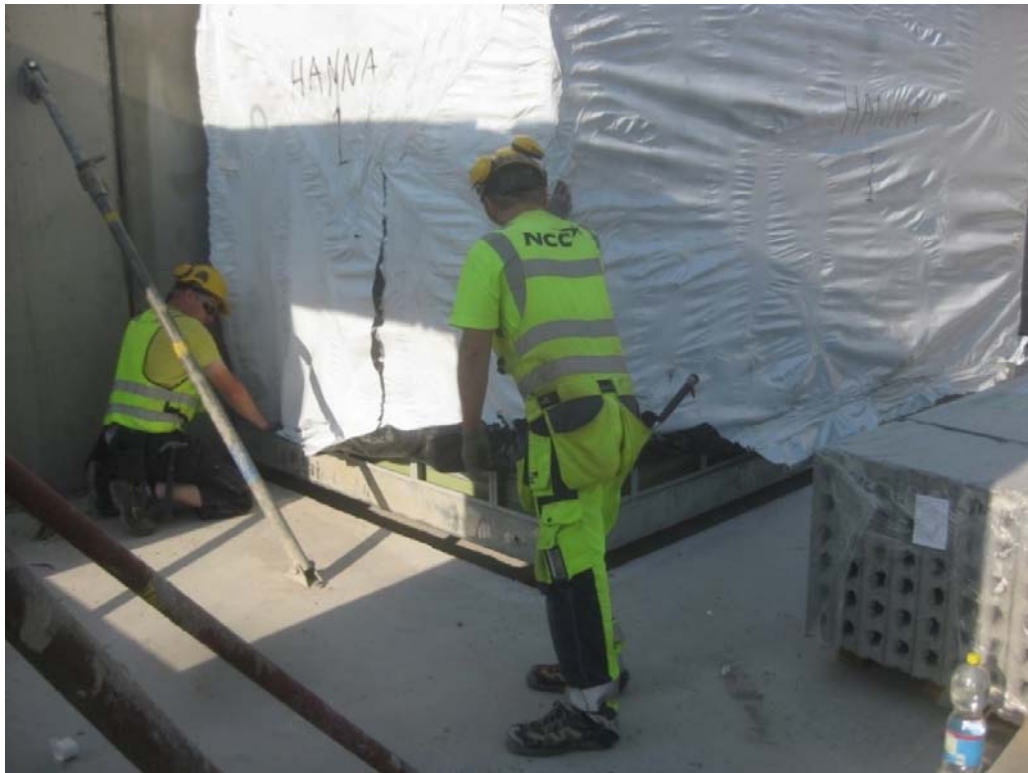
Kuva 9. Kylpyhuone-elementtiä asennetaan maanvaraiselle laatalle Hollolan Hannan työmaalla. (Kuva: Petja Syrjäläinen 2013)
