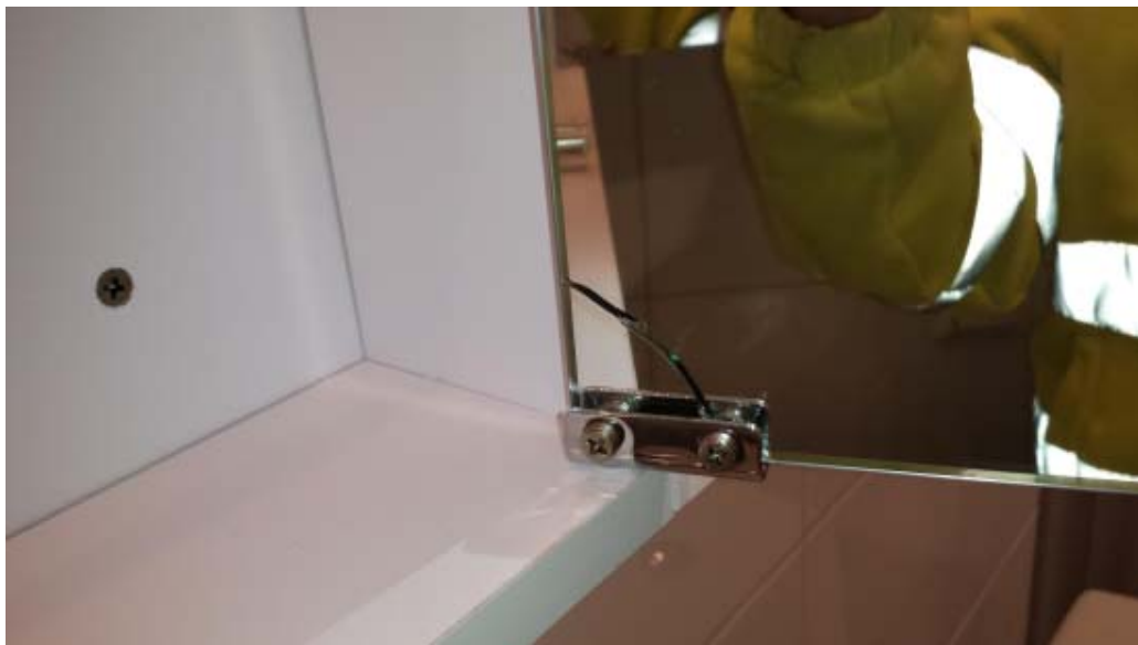
Kuva 11. Pelikaapin rikkoutunut peili Hollolan Hannan työmaalla. (Kuva: Kristian Rantaharju 2014)
