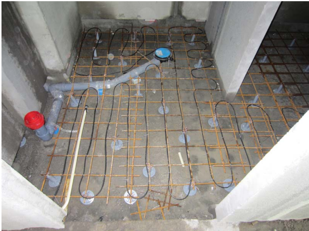
Kuva 13. Kylpyhuoneosasto ennen lattiabetonointia. Kuva on NCC:n aiemmasta kohteesta vuodelta 2012. (Kuva: Matti Luostarinen 2012)
